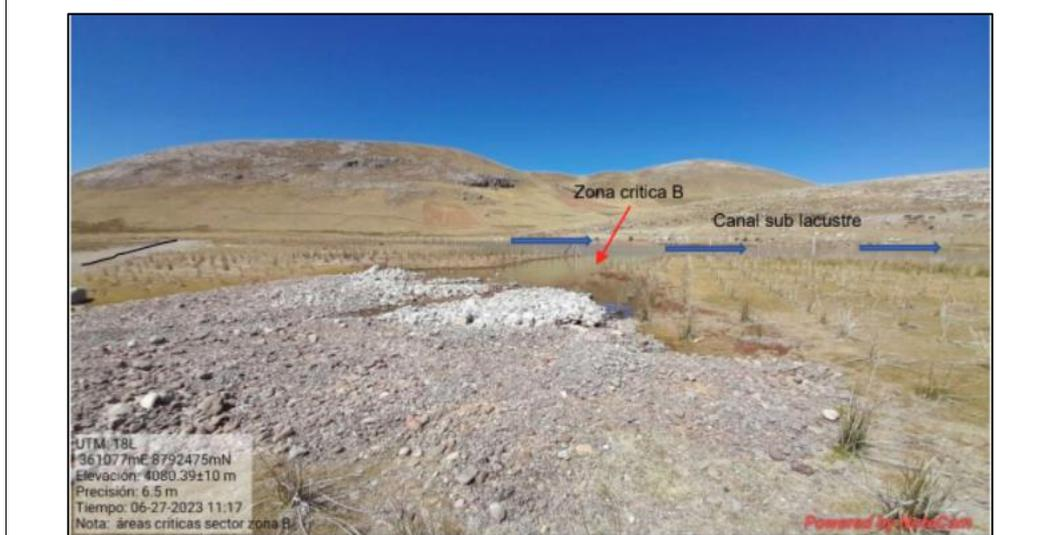
**Fotografía N° 2 (20230627\_111751):** Vista de la zona crítica B, del "Delta Upamayo A", se observa que en el tramo de la zona crítica existe un ingreso de agua desde el canal lacustre hasta la zona de remediación, donde se observó material de préstamo tipo piedra chancada, lo que limita que llegue al acceso interno (área)
