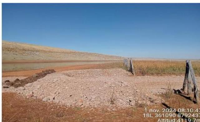
Fotografía 7. Vista de la zona crítica "B" rellenada, nivelada, perfilada junto al pequeño dique;
