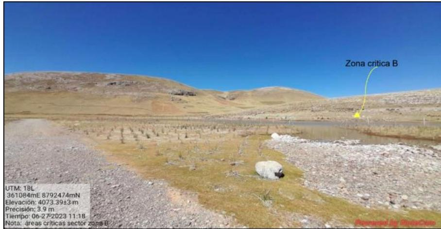
**Fotografía N° 3 (20230627\_111833):** Vista de la **zona crítica B**, del "Delta Upamayo A", se observa que el tramo de la zona crítica existe ingreso de agua desde el canal lacustre a la zona de remediación, no cuenta con cerco perimétrico, colindante a la zona, no se observó área revegetada donde se dispuso material de préstamo. **Fecha 27 de junio de 2023.**
