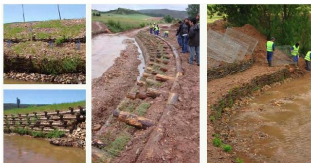
Figura IX. Estructuras de bioingeniería (faginas y krainer) usadas para estabilizar orillas (Riba de Saelices, Guadalajara).
