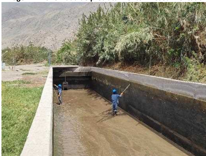
Imagen N° 16: Unidad de pretratamiento: Presedimentador
