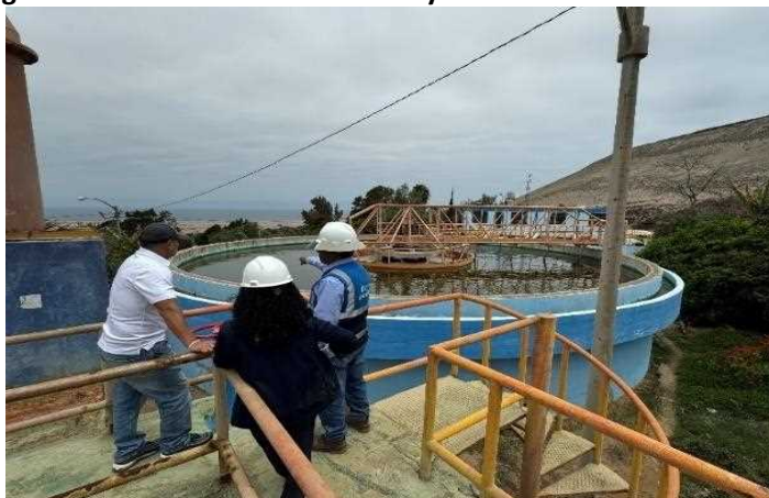
Imagen N° 22: Unidad de floculación y decantación - PTAP Cata Catas
