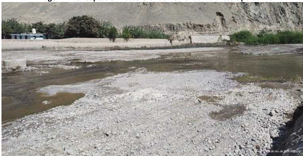
Imagen N° 13: Captación Pasto Grande - Galerías filtrantes Operativas
