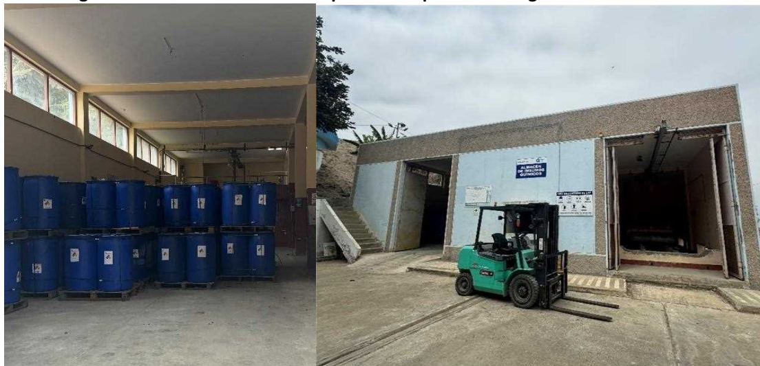
Imagen N° 26: Almacenamiento de productos químicos: Coagulante – PTAP Cata Catas
