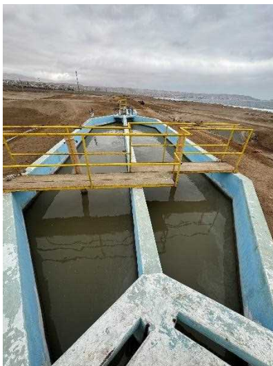
Imagen N° 68: Desarenador – PTAR Media Luna
