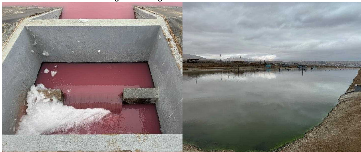
Imagen N° 73: Lagunas terciarias – PTAR Media Luna
