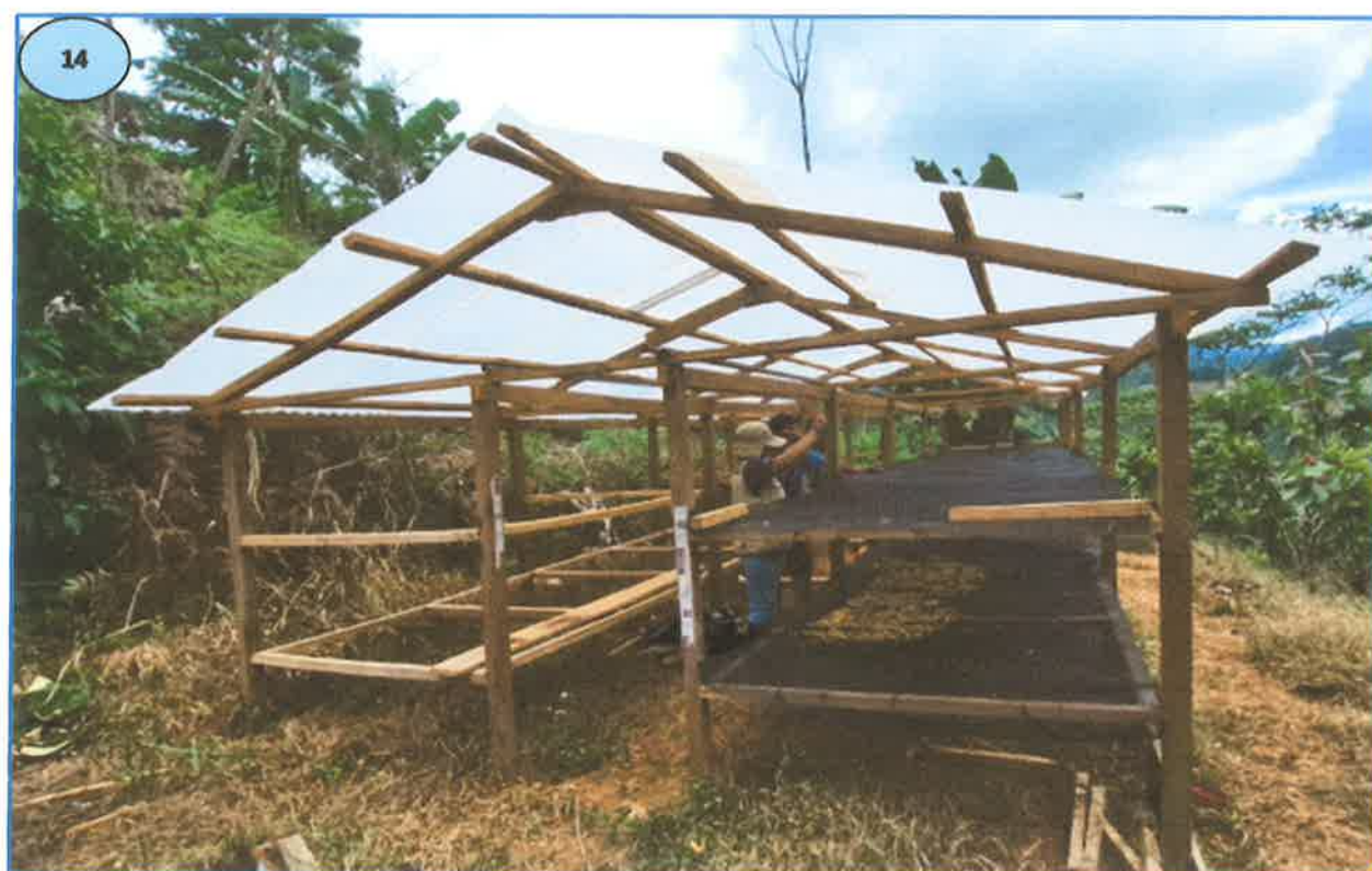
14: Secadora solar (4mx10m) a implementarse en la comunidad.
