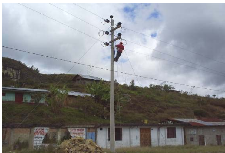
Montaje red Primaria en localidad de Vilcaniza Electrificación Amazonas Sector I Provincia de Bongará, Departamento de Amazonas
