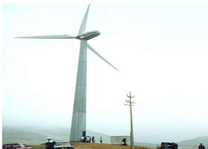
Aerogenerador instalado de 450 kW Provincia de Marcona, Departamento de Ica
