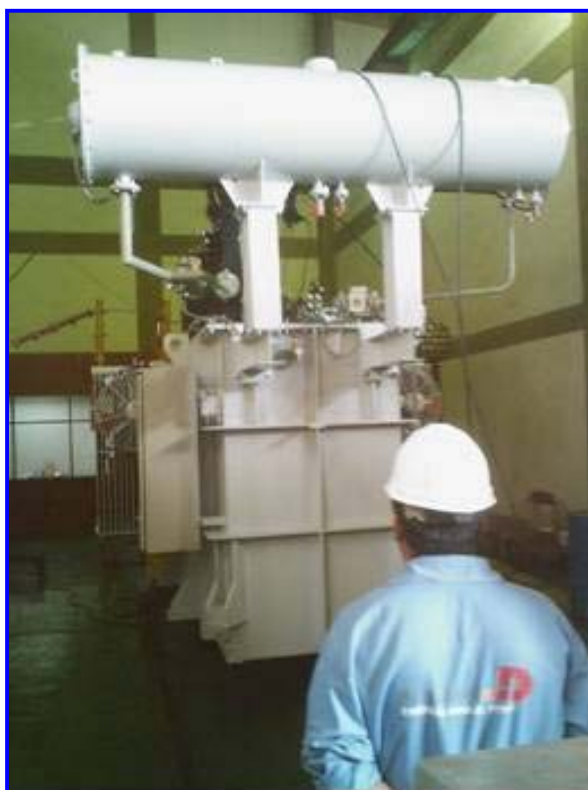
Prueba de Transformador 4-5 MVA para Subestación San Francisco Línea de Transmisión 66 kV Ayacucho – San Francisco
