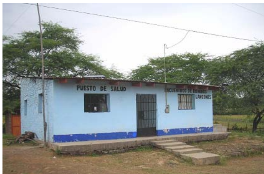
Acometida Domiciliaria Puesto de Salud Encuentro de Romero Interconexión Eléctrica Perú-Ecuador III Etapa Provincia de Sullana, Departamento de Piura
