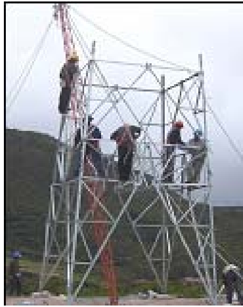
Izado de Torre de Alta Tensión Línea de Transmisión Carhuquero - Jaén Departamento de Cajamarca
