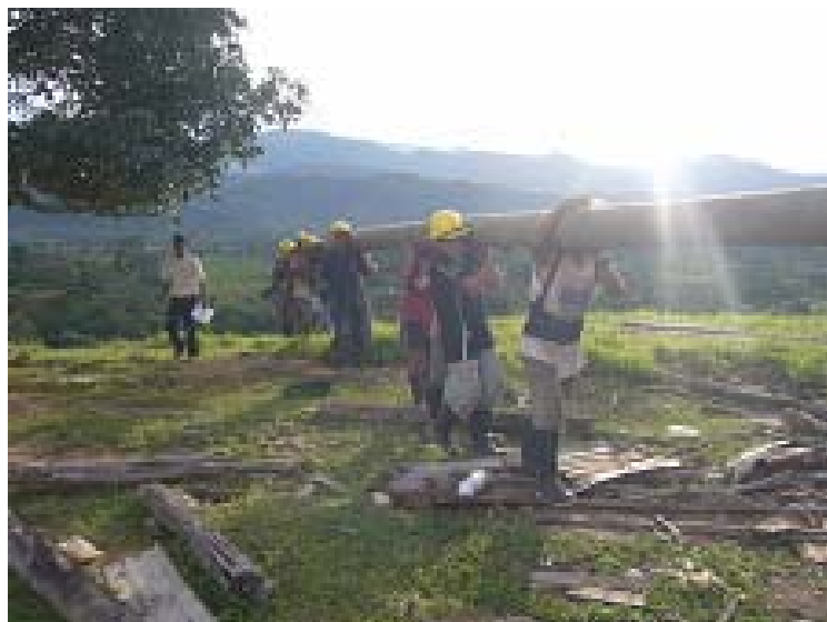
Traslado de postes a punto de izaje Electrificación tres ramales de Tocache Provincia de Tocache, Departamento de San Martín
