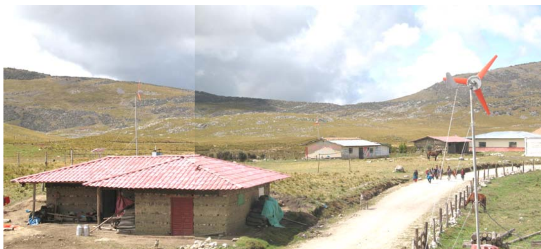
Sistemas Híbridos Eólico – Fotovoltaico de 150 W Comunidad de Campo Alegre en Cajamarca
