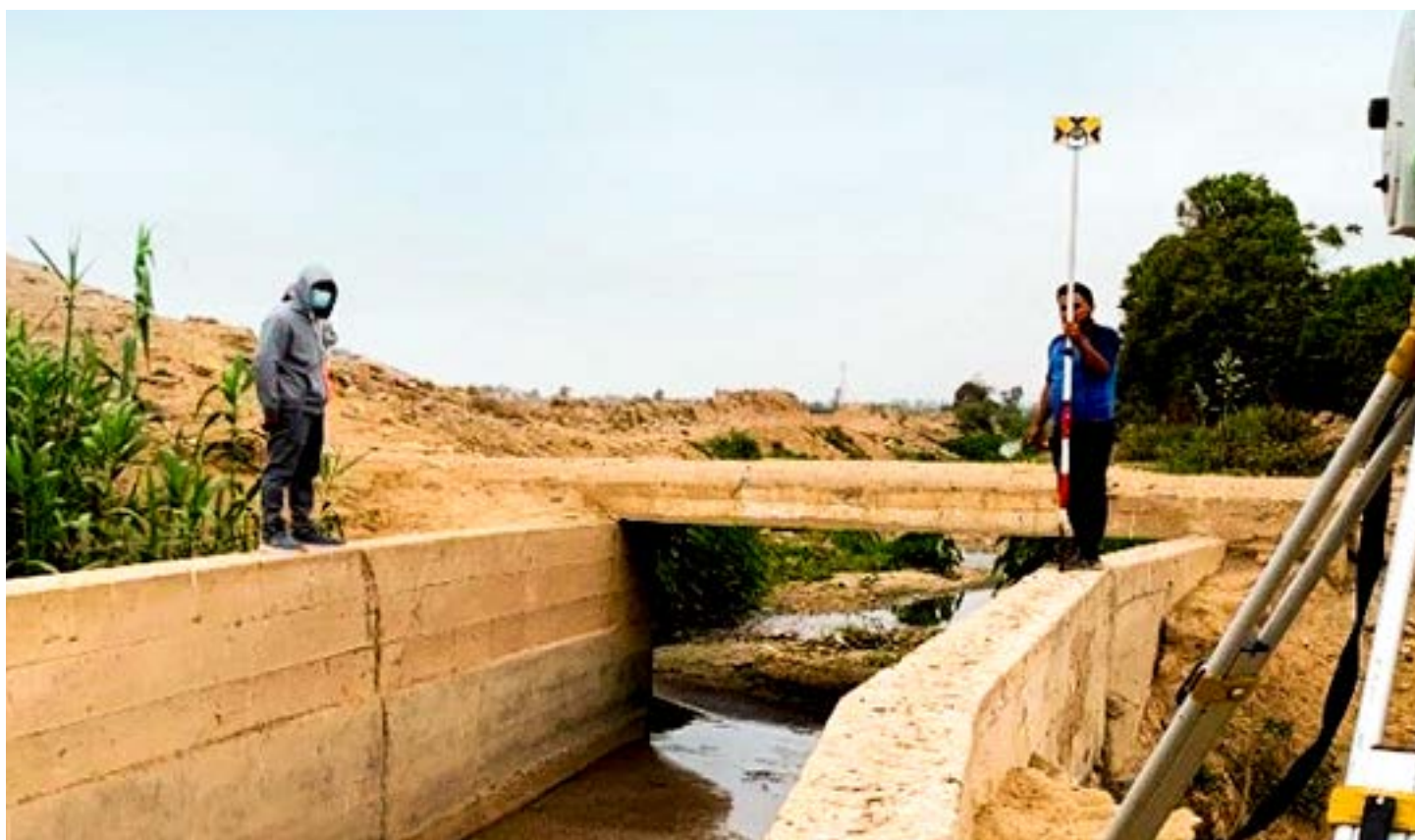
La Dirección Regional de Agricultura de Lima anunció en 2021 la culminación de los estudios para construcción de un revestimiento de concreto al canal María Angola en Cañete.
