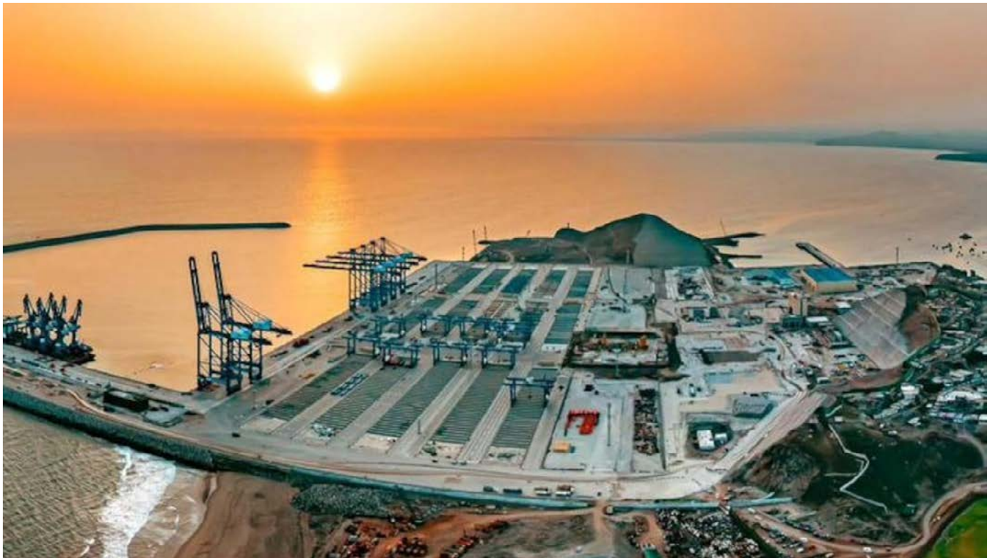
Porto de Chancay
