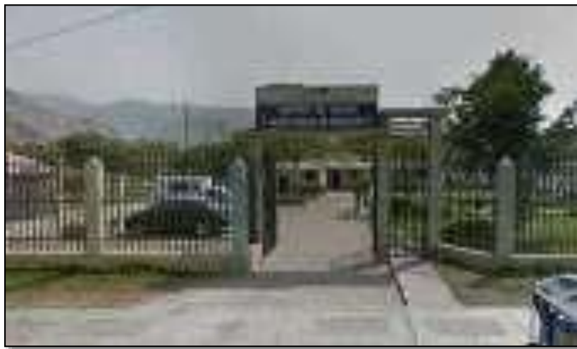
Foto N° 1. Frontis del C.S. Santa María de Huachipa
