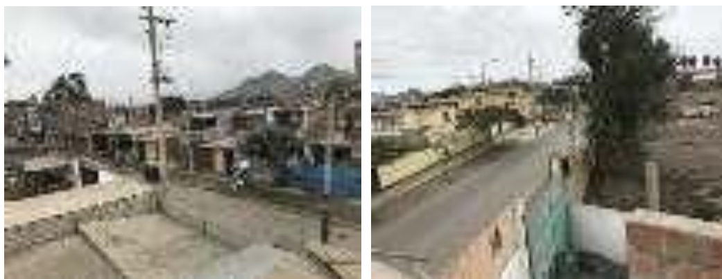
Foto N° 25. Vías de acceso al área de consultorios externos del centro de salud
