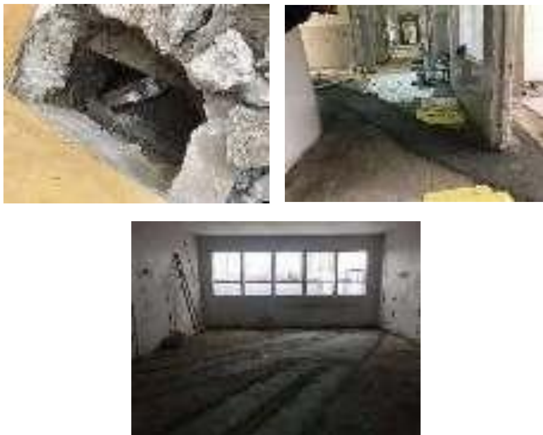
Foto N° 61. Nueva red de alcantarillado
