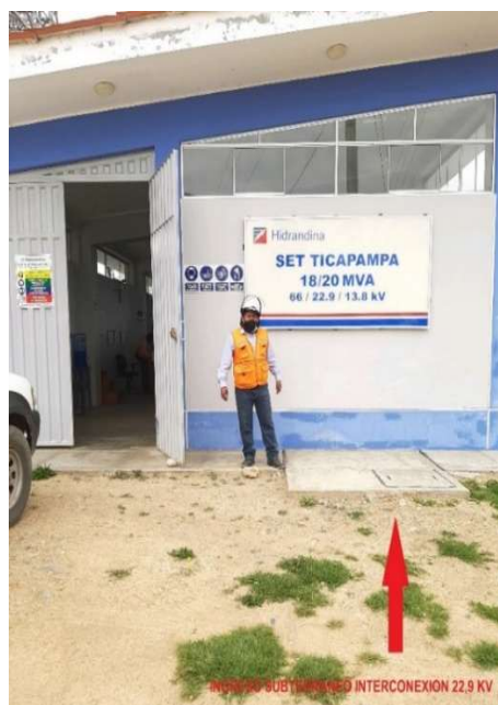
Figura N°2: Punto de Interconexión, Inicio con Cable Subterráneo
