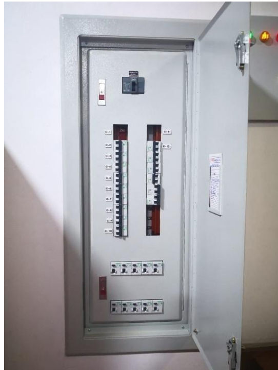
Figura 6. Tablero eléctrico del equipo mayor (espectrofotómetro-espectrómetro de emisión atómica multielemental).
