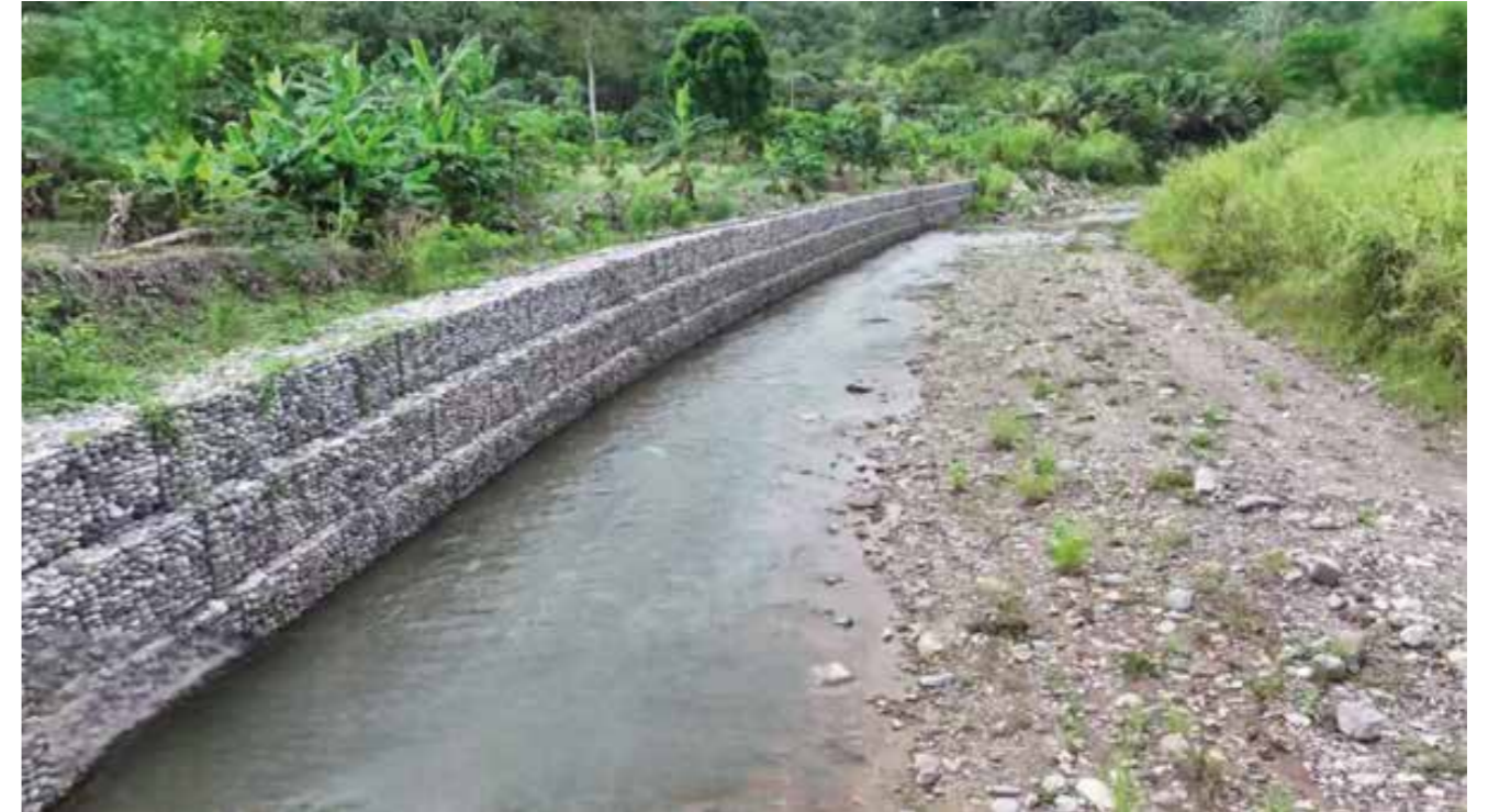
Defensa ribereña y área de protección- PEPP
