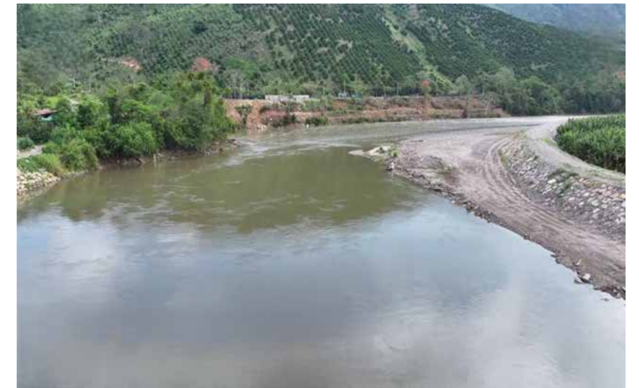
Defensa ribereña y área de protección- PEPP
