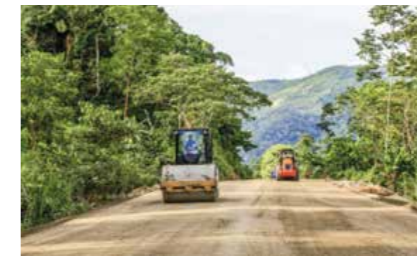
Carretera "Via Pichis" - PEPP
