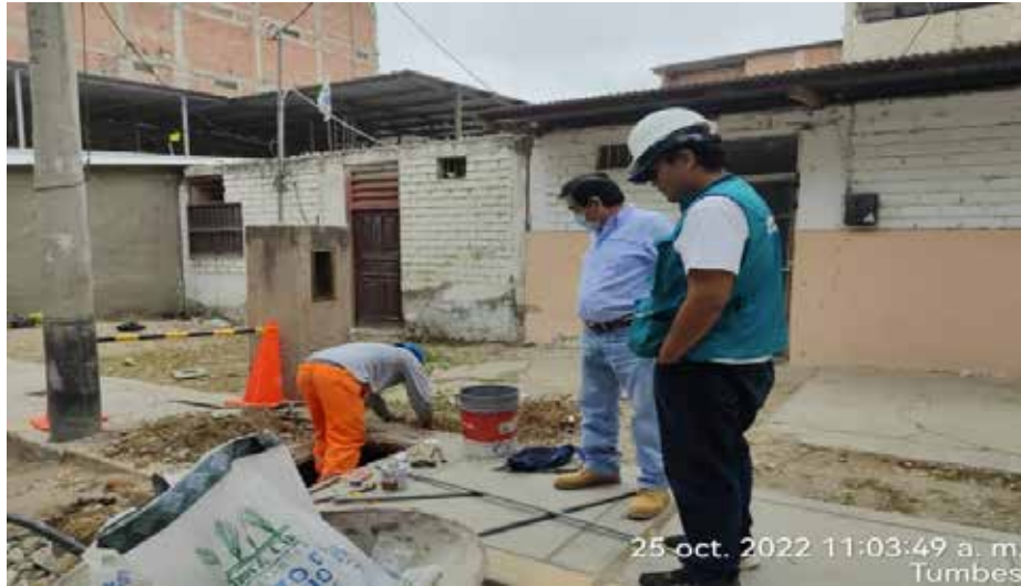
Imagen 22. Supervisión de la instalación de medidores
