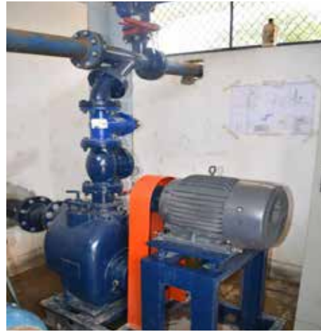
Imagen 17. Instalación de equipo de bombeo de captación de la PTAP La Peña
