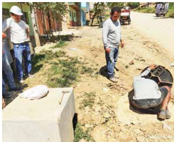
Imagen 10. Cámara de válvula reductora de presión IOARR: Optimización redes de distribución de agua potable de Eps-mu S.A. distrito de Bagua, provincia de Bagua, departamento de Amazonas.
