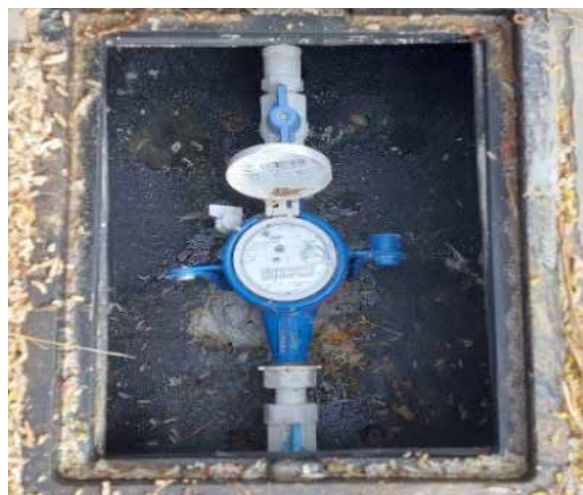
Imagen N° 21. Medidores instalados
