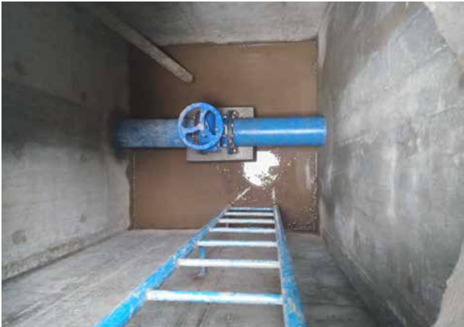
Imagen 12. | Construcción de Cámara e instalación de válvulas de purga de sólidos
