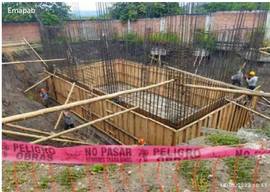
Imagen 8. IOARR: Construcción de la línea de impulsión en la Empresa municipal de agua potable y alcantarillado de Bagua S.A., distrito de Bagua.
