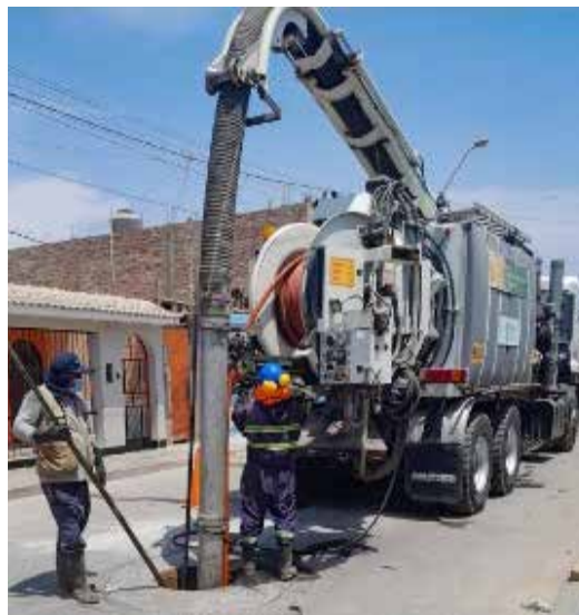
Imagen 4. Mantenimiento de redes en Av. Andrés Belaunde cruce Jr. San Martín de Pobres, distrito de Pueblo Nuevo, provincia de Chincha
