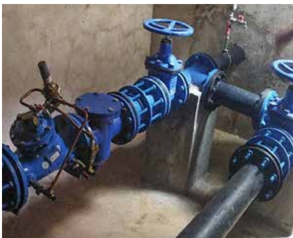
Imagen 9. Cámara de válvula reductora de presión y válvula de aire
