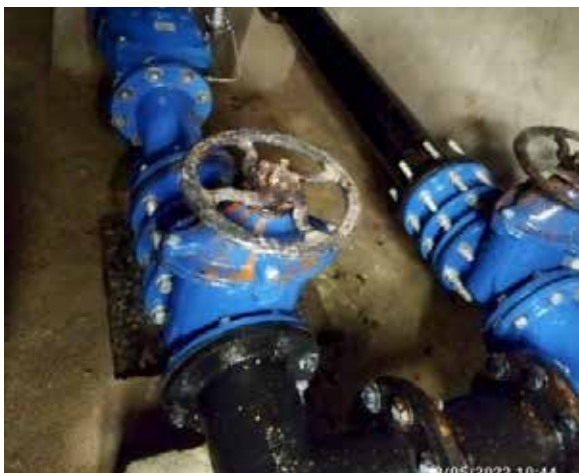
Imagen 10. Cámara de válvula reductora de presión IOARR: Optimización redes de distribución de agua potable de Eps-mu S.A. distrito de Bagua, provincia de Bagua, departamento de Amazonas.
