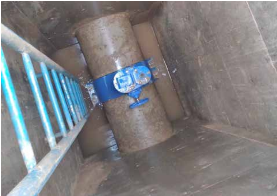
Imagen 11. | Construcción de Cámara e instalación de Válvulas de Aire
