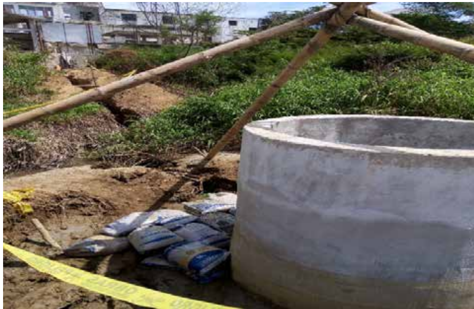
Imagen 23. Construcción de tanque para la captación de agua
