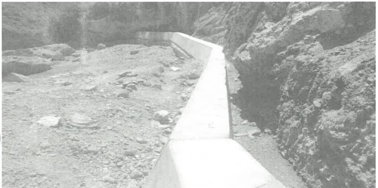
Muro de contención para protección de línea de conducción con tubería HDP.
