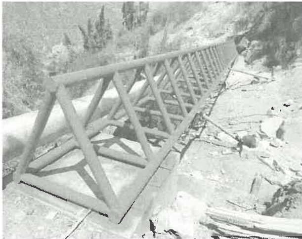
Muro de contención para protección de línea de conducción con tubería HDP.
