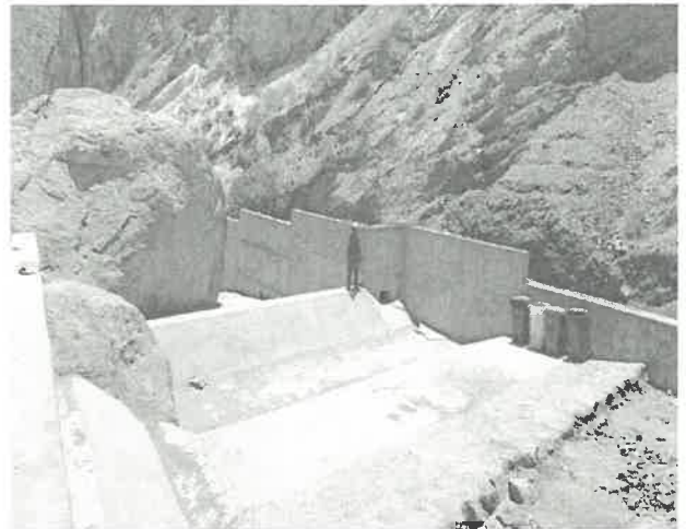
Estructura de acero para el pase de línea de conducción con tubería HDP
