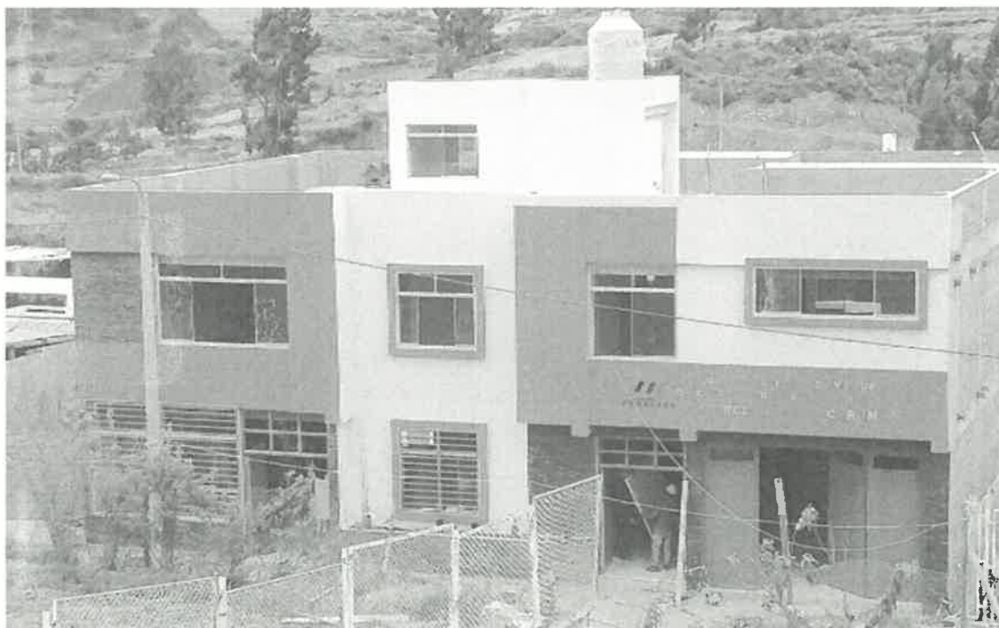
Infraestructura de la Agencia Agraria Carumas
