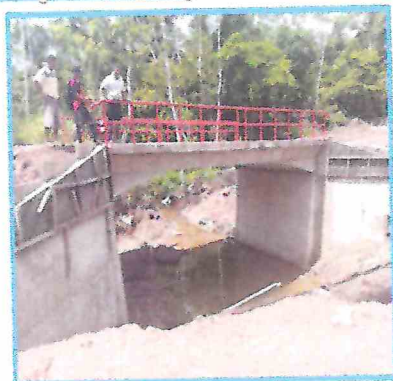
IMAGEN 16. Se aprecia la ejecución de la partida 03.01.05.01 BARANDA METALICA
