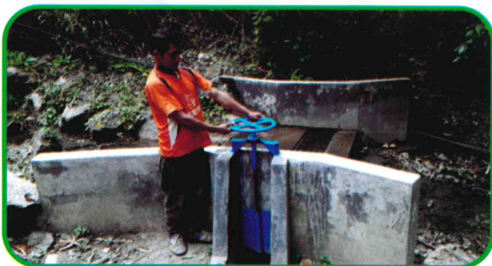
FOTO N 01: Operación de la Compuerta Metálica – Tonccopara.
