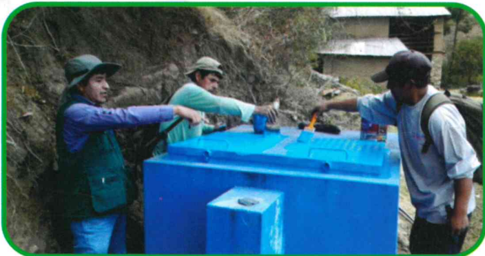
FOTO N 11: Mantenimiento de la cámara de carga – Tonccopara
