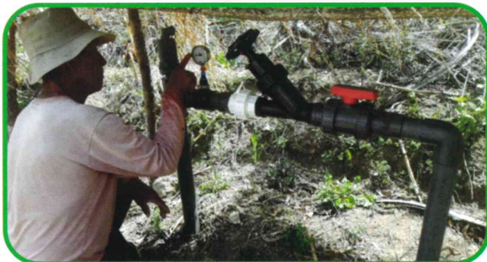
FOTO N 25: Arco de riego - Tonccopara
