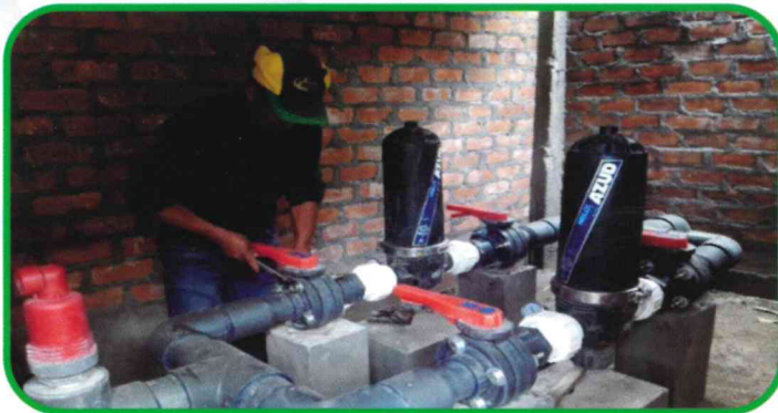
FOTO N 14: Cabezal de filtrado de Tonccopara
