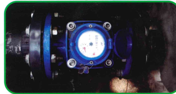
FOTO N 15: Caudalímetro de Tonccopara
