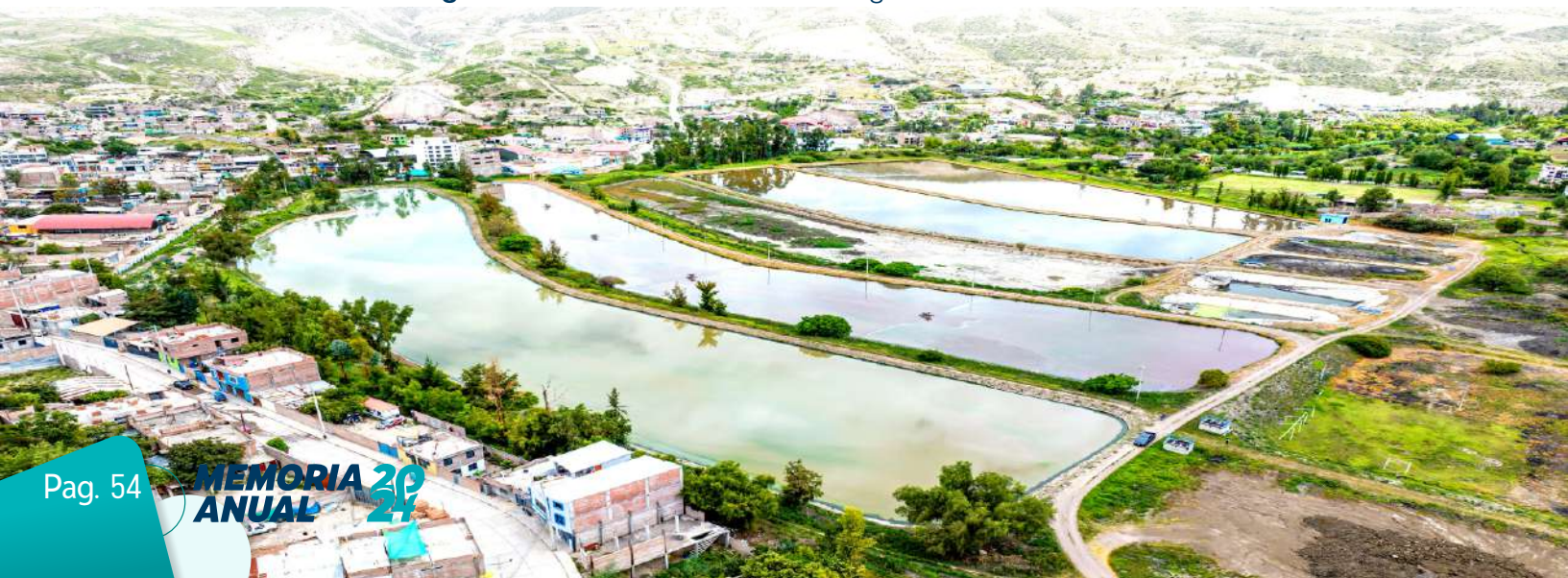
Imagen N° 18 Planta de tratamiento de aguas residuales- Totorá
