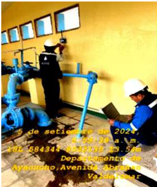
Imagen N° 28 Instalación de data loggers para el monitoreo avanzado para la optimización de redes de agua potable
