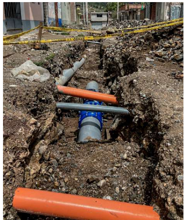
Imagen N° 21 Reubicación de red matriz tubería de agua potable en el Jr. Américo Oré.
