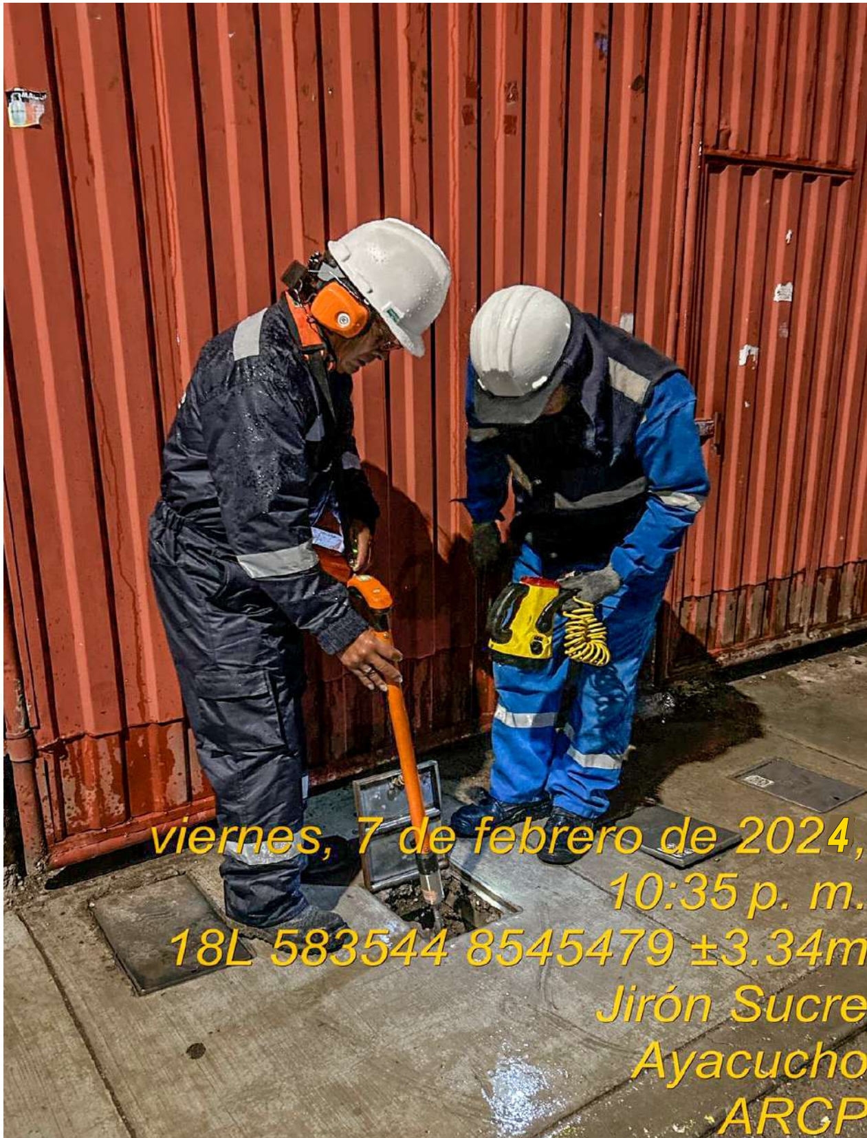
Imagen N° 29 Detección de fugas con miras a los avances en la gestión eficiente de las redes de agua potable
