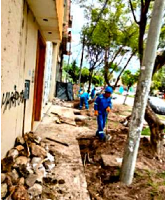
Imagen N° 22 Reubicación de tubería de alcantarillado en la Av. Aviación 5ta cuadra – Distrito Andrés Avelino Cáceres
