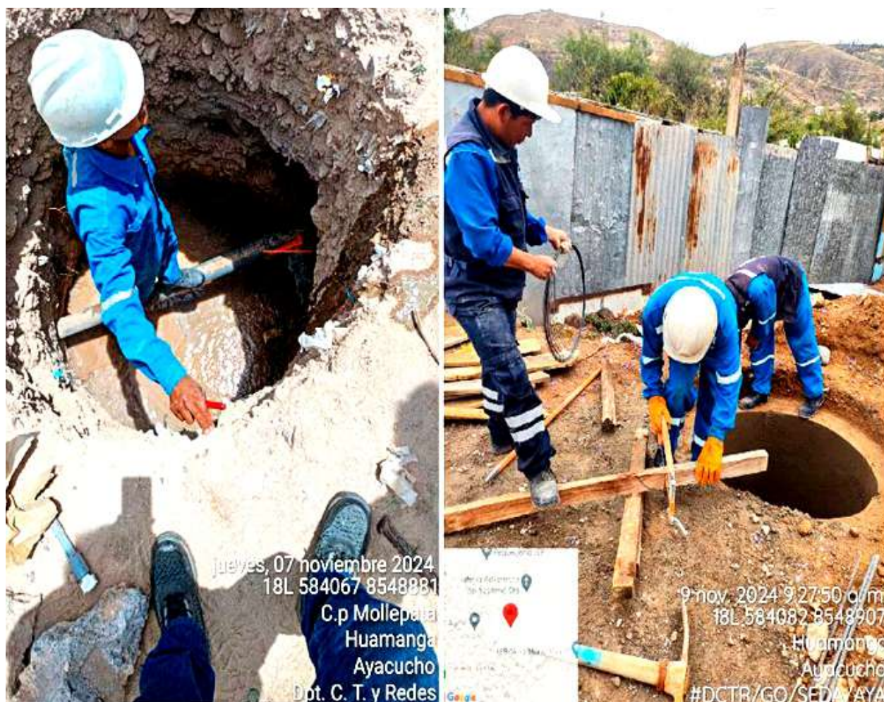
Imagen N° 25 Reducción de riesgos y mejora del flujo mediante la instalación de válvulas de aire en las redes de agua potable”
