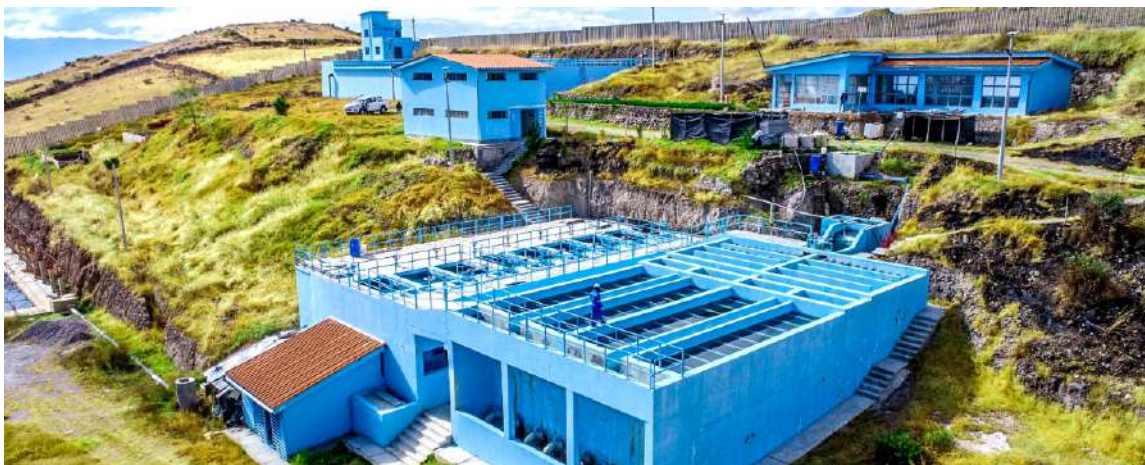
Imagen N° 31 Planta de tratamiento de agua potable de Cabrapata
