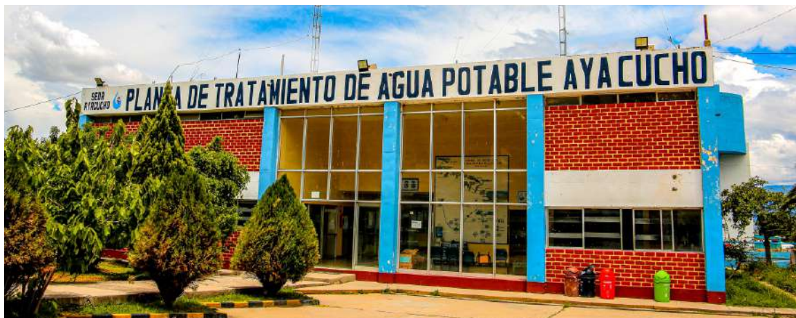
Imagen N° 10 Planta de tratamiento de agua potable Ayacucho
