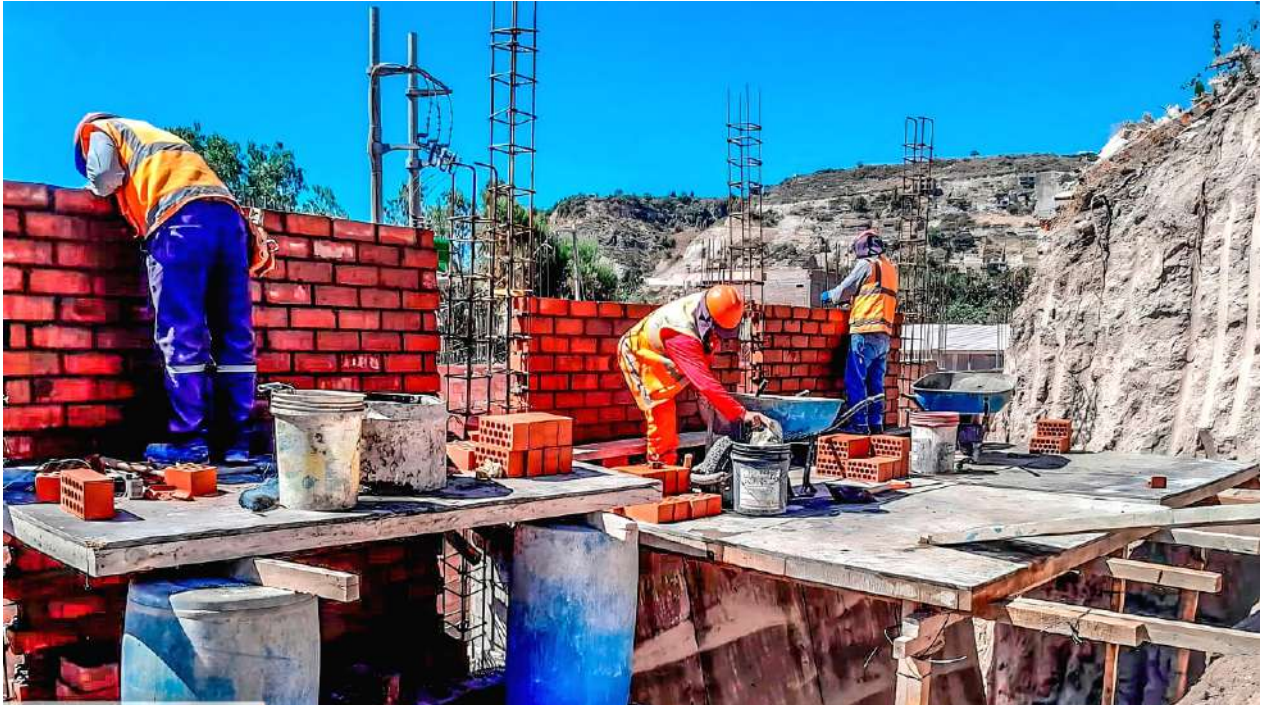
Imagen N° 52 Proceso de ejecución del Cerco Perimétrico en la Planta de Tratamiento
