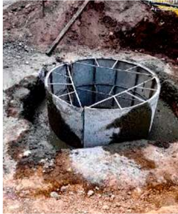
Imagen N° 23 Construcción de buzón desarenador en Asoc. María Magdalena y Jr. Los Angeles Av. 26 de enero
