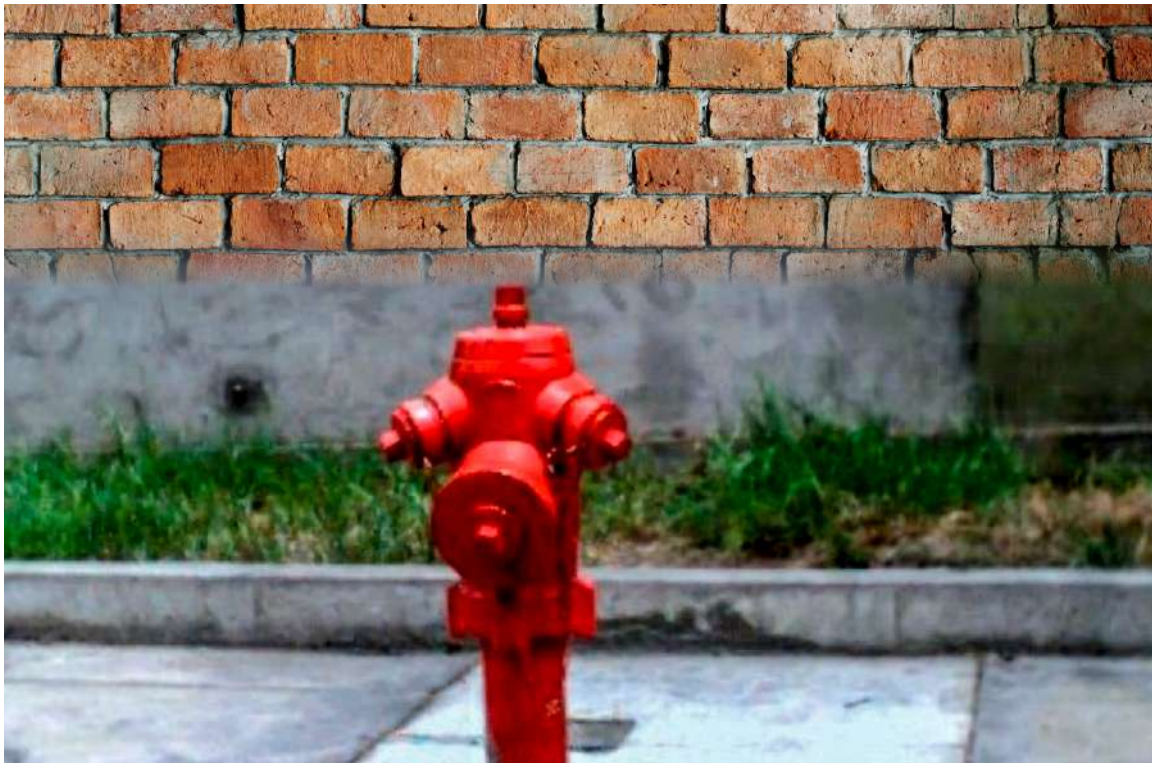
Imagen N° 24 Instalación de grifos contra incendio en la Av. Ayacucho entre la Asoc. 4 de Febrero Vista Alegre, y en la Av. Daniel Alcides Carrión (frontis Hospital Regional)
