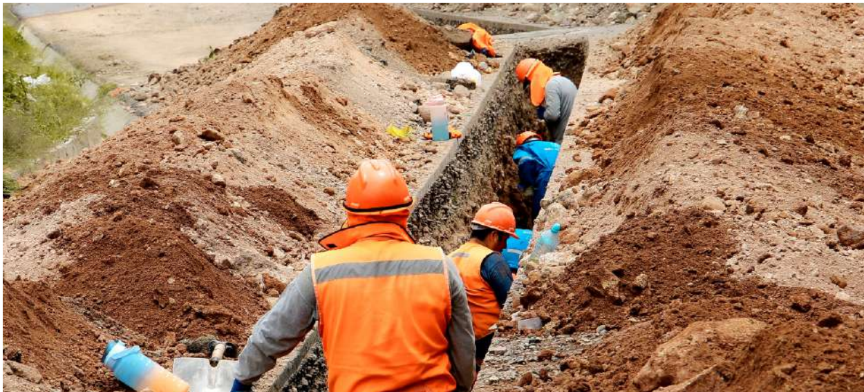
Imagen N° 46 Trabajos para la renovación de tuberías de la Av. Cuzco, Av. Arenales y Jr. Untiveros
