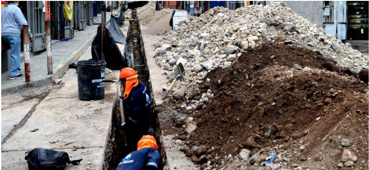
Imagen N° 20 Mantenimiento preventivo y correctivo , a las redes de agua y alcantarillado
