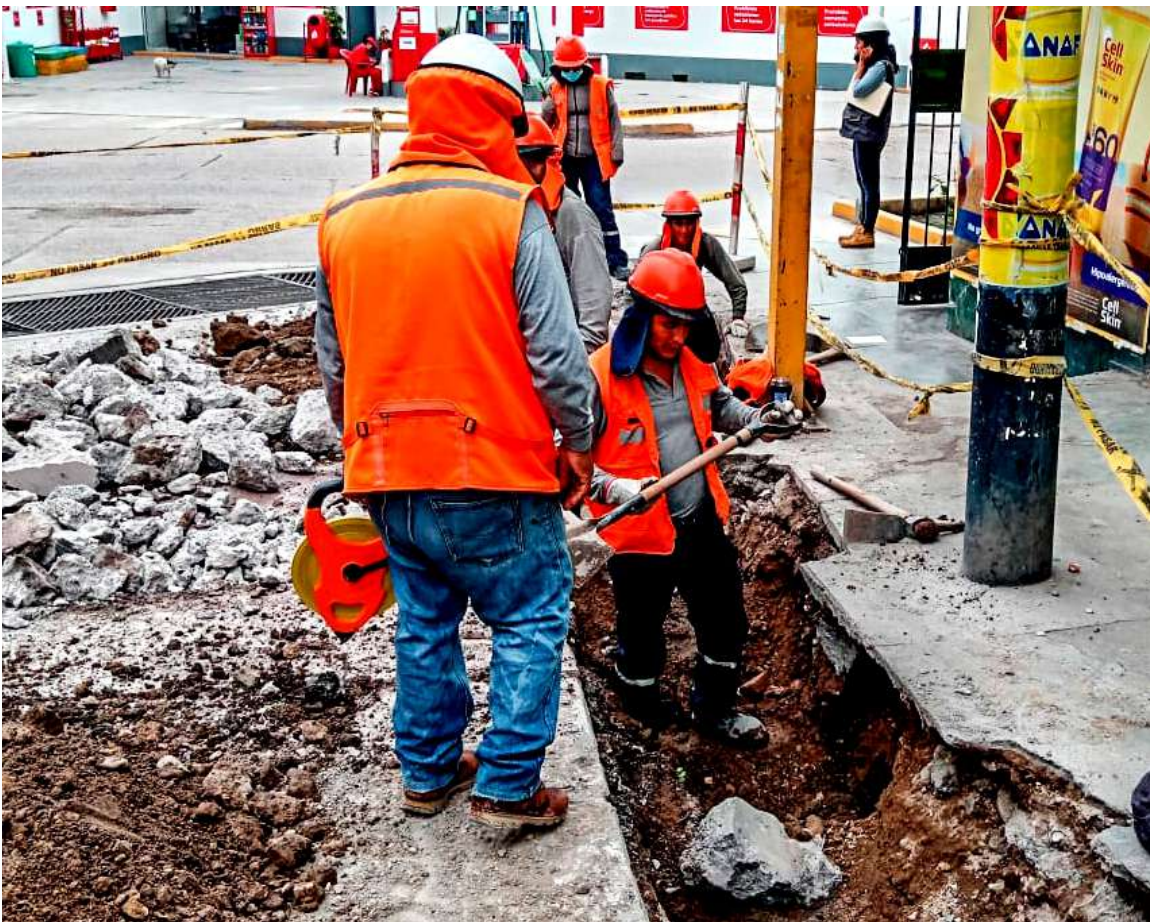
Imagen N° 45 Trabajos para la renovación de tuberías de la Av. Los Incas hasta la Av. Ramón
