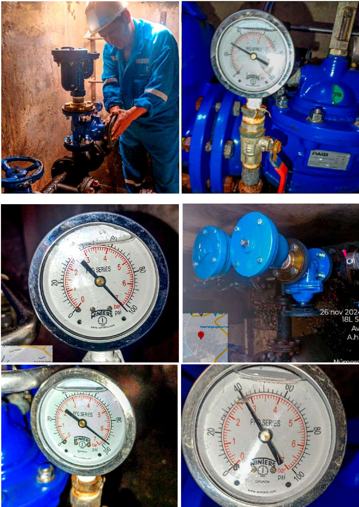
Imagen N° 26 Ajuste y precisión mediante la renovación de manómetros para un control
