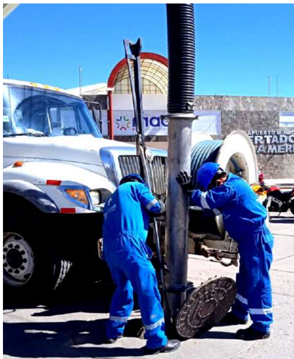
Imagen N° 20 Mantenimiento preventivo y correctivo , a las redes de agua y alcantarillado
