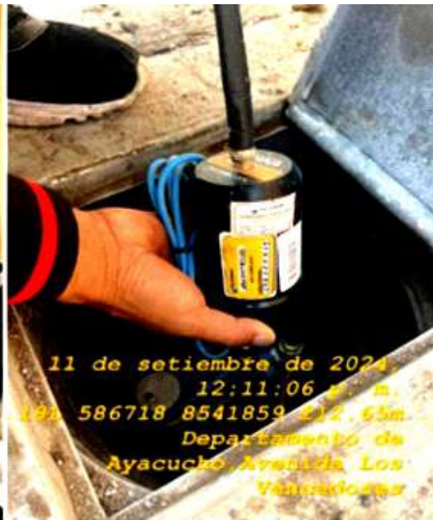
Imagen N° 28 Instalación de data loggers para el monitoreo avanzado para la optimización de redes de agua potable
