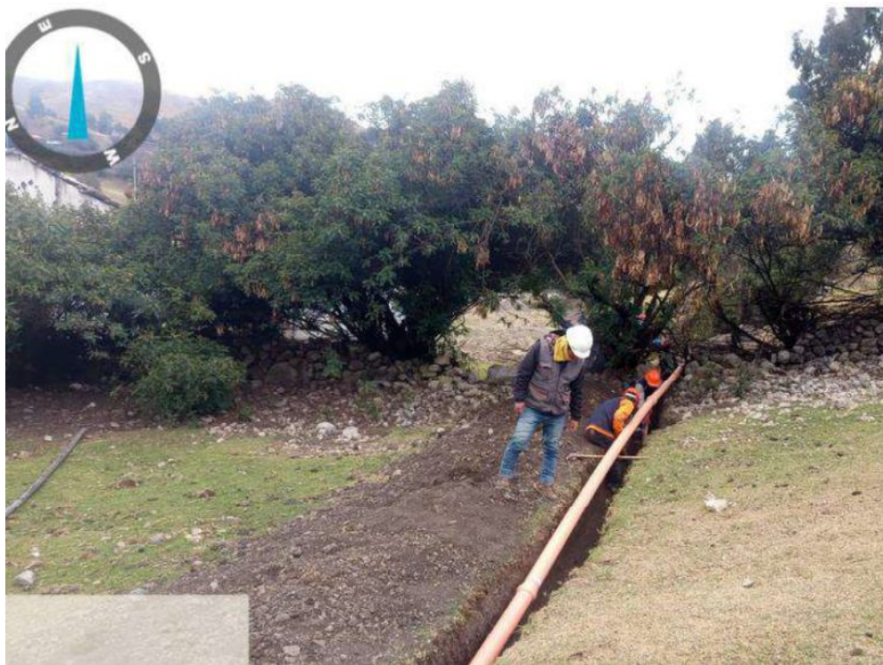
FOTOGRAFÍA N°13 LA IMAGEN EVIDENCIA LOS TRABAJOS DE INSTALACION DE TUBERIAS PVC EN RED DE DISTRIBUCION
