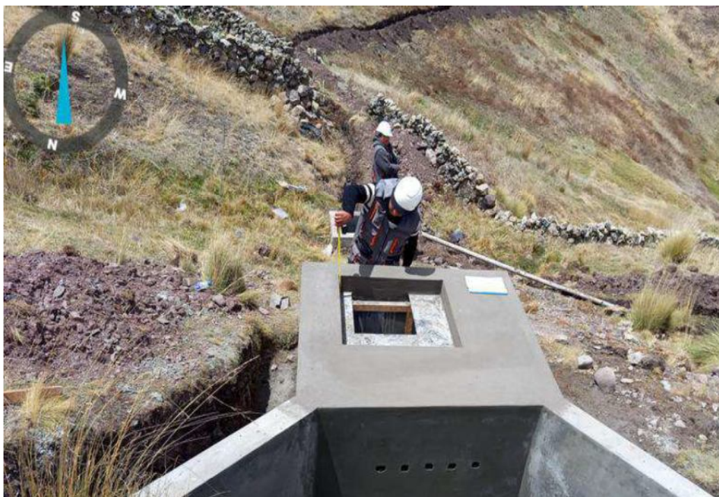
FOTOGRAFÍA N°09 LA IMAGEN EVIDENCIA LOS TRABAJOS DE TARRAJEO EN CAPTACION TIPO LADERA
