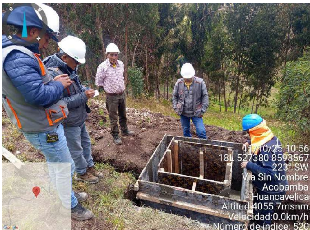
FOTOGRAFÍA N°16 LA IMAGEN EVIDENCIA LOS TRABAJOS DE ENCOFRADO Y VACEADO DE CONCRETO EN CAJAS DE INSPECCION
