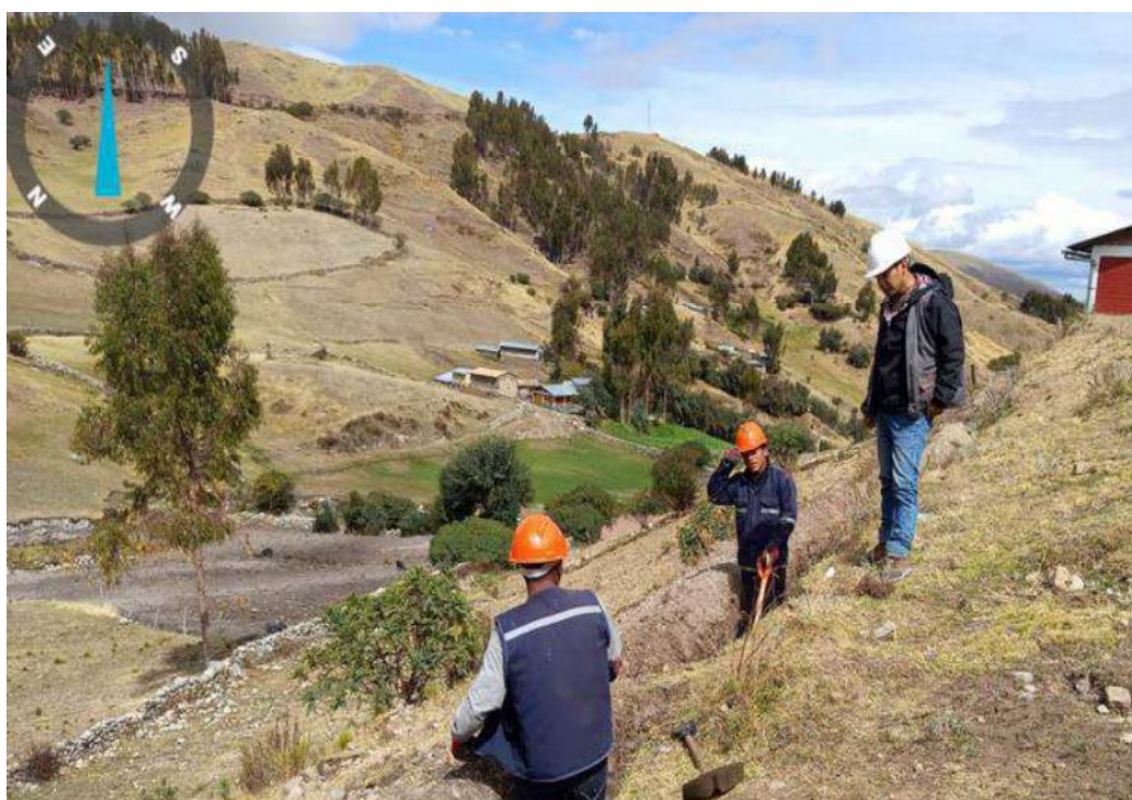
FOTOGRAFÍA N°06 LA IMAGEN EVIDENCIA LOS TRABAJOS DE EXCAVACION DE ZANJA EN LINEAS DE CONDUCCION
