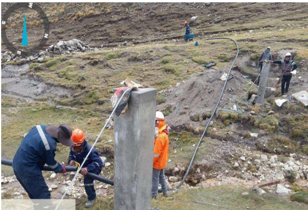
FOTOGRAFÍA N°07 LA IMAGEN EVIDENCIA LOS TRABAJOS EN EL PASE AEREO CON LOS ACCESORIOS RESPECTIVOS
