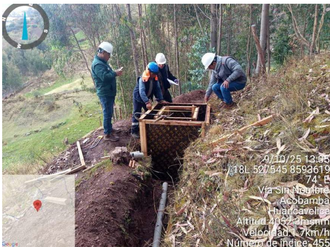
FOTOGRAFÍA N°05 LA IMAGEN EVIDENCIA LOS TRABAJOS DE ENCOFRADO DE CAJAS DE INSPECCION
