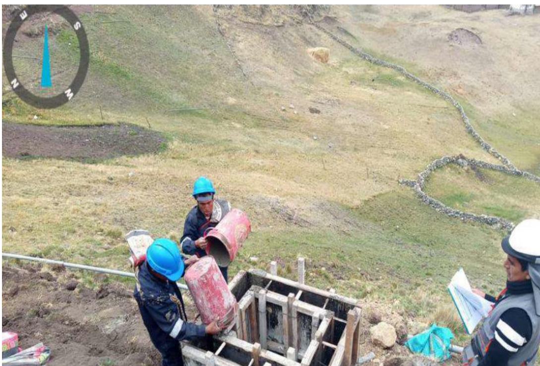
FOTOGRAFÍA N°08 LA IMAGEN EVIDENCIA LOS TRABAJOS DE VACEADO DE CONCRETO EN CAJAS DE INSPECCION
