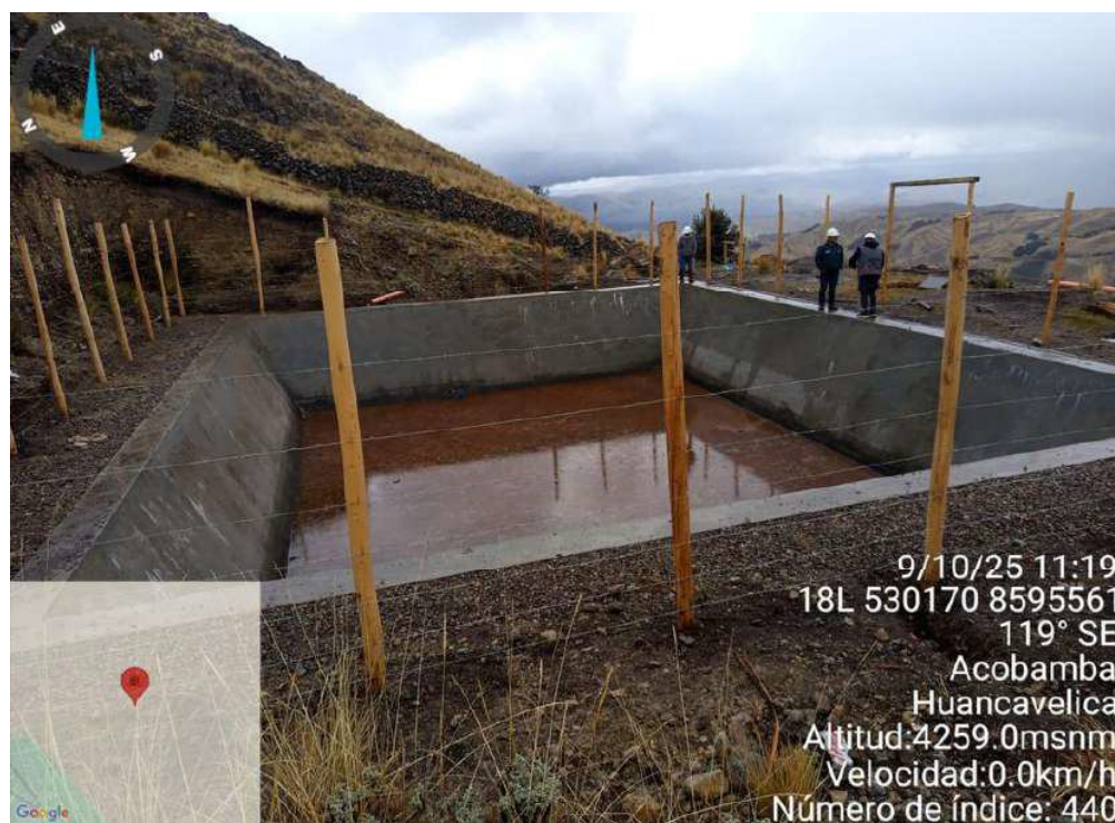
FOTOGRAFÍA N°15 LA IMAGEN EVIDENCIA LOS TRABAJOS DEL SISTEMA DE DRENAJE EN EL RESERVORIO
