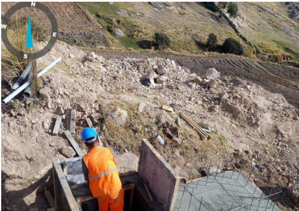
FOTOGRAFÍA N°11 LA IMAGEN EVIDENCIA LOS TRABAJOS ENCOFRADO Y VACEADO DE CAJAS DE VALVULA
