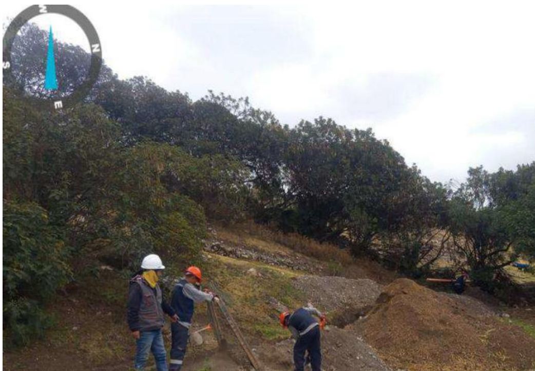
FOTOGRAFÍA N°12 LA IMAGEN EVIDENCIA LOS TRABAJOS DE SARANDEO DE MATERIAL SELECCIONADO PARA CAMA EN LINEA DE DISTRIBUCION
