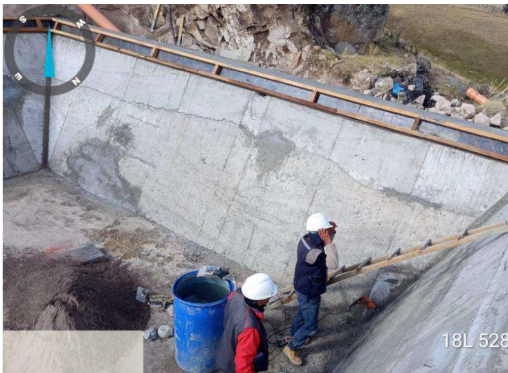
FOTOGRAFÍA N°10 LA IMAGEN EVIDENCIA LOS TRABAJOS DE TARRAJEO CON IMPERMEABILIZANTE EN EL RESERVORIO DE 150M3
