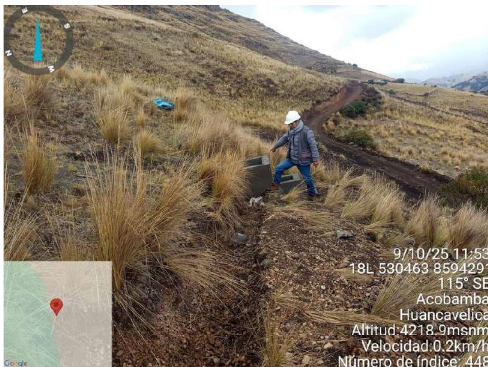
FOTOGRAFÍA N°14 LA IMAGEN EVIDENCIA LOS TRABAJOS DEL VACEADO DE CONCRETO EN CAJAS DE INSPECCION
