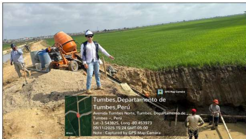
FOTO 21.-VACIADO DE ZAPATAS PANTALLA MURO DREN
