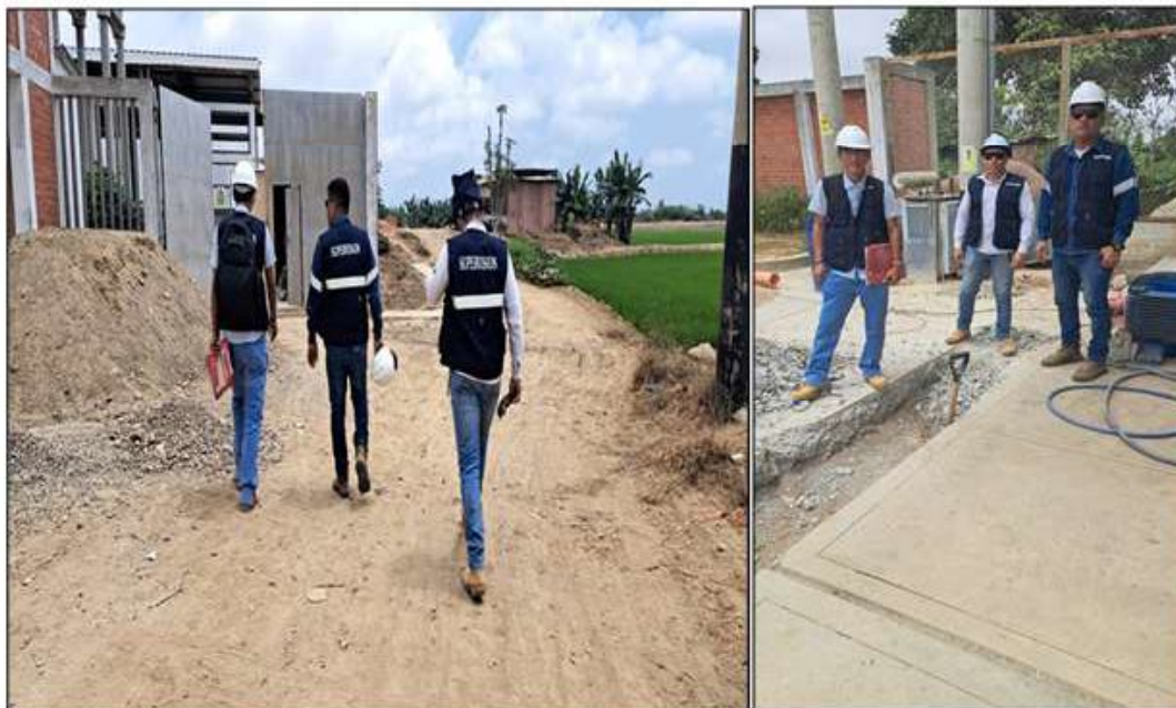
Fotografía 01 y 02. Recorrido de obra para verificar las medidas de seguridad en los diferentes frentes de trabajo.
