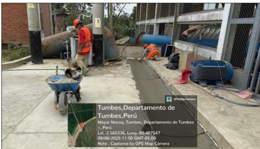
Fotografía 11. Verificación de los trabajos de tarrajeo en cuneta.
