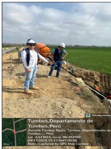
FOTO 20.-VACIADO DE ZAPATAS PANTALLA MURO DREN
