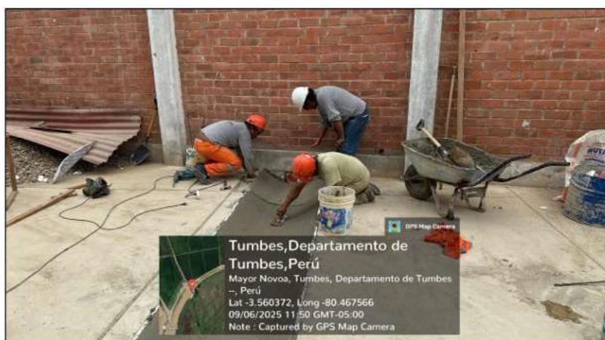
Fotografía 11. Verificación de los trabajos de tarrajeo en cuneta.
