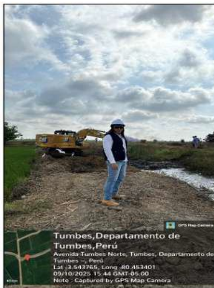
FOTO 19.-TRABAJOS EN MURO DREN
