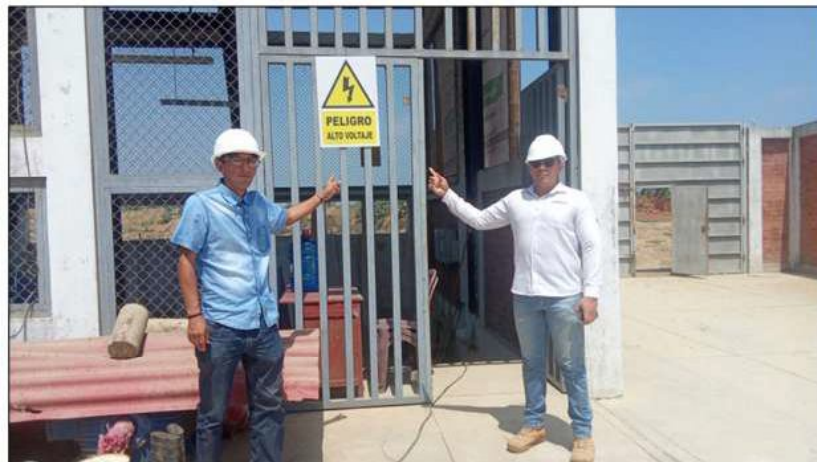
FOTO 09 VERIFICACION DE SEÑALIZACION
