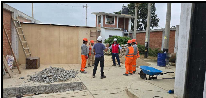
FOTO 16.-CHARLAS DIARIAS DE 10 MINUTOS AL PERSONAL OBRERO EN PRESENCIA DEL ING. DE SEGURIDAD Y PREVENCIONISTA
