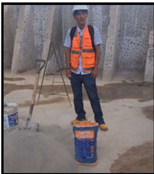
FOTO 22.-VERIFICACION DE ADITIVO
