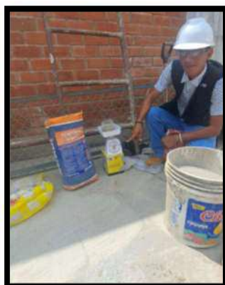
FOTO 06.- VERIFICACION DE ADITIVO PENETRON
