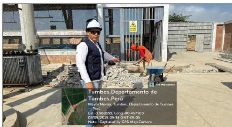
FOTO.05 - PICADO Y DEMOLICION
