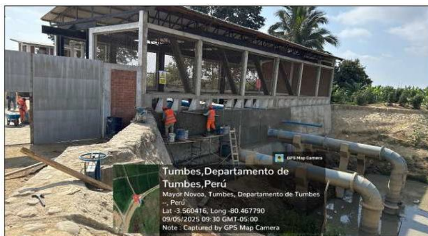
FOTO 03.- TARRAJEO CON IMPERMEABILIZANTE
