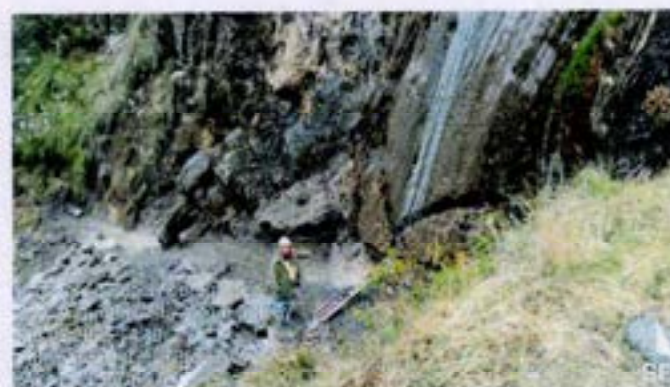
FOTO 12: LIMPIEZA DE LINEA DE CONDUCCIÓN.
