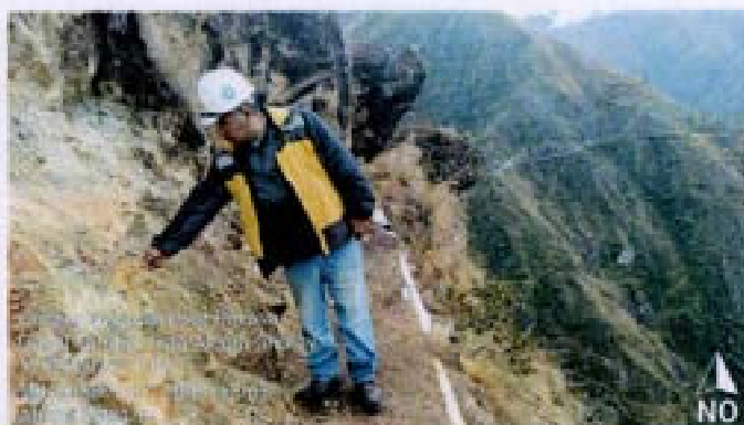
FOTO 29: EXCAVACION EN ROCA FIJA-LINEA DE CONDUCCIÓN.
