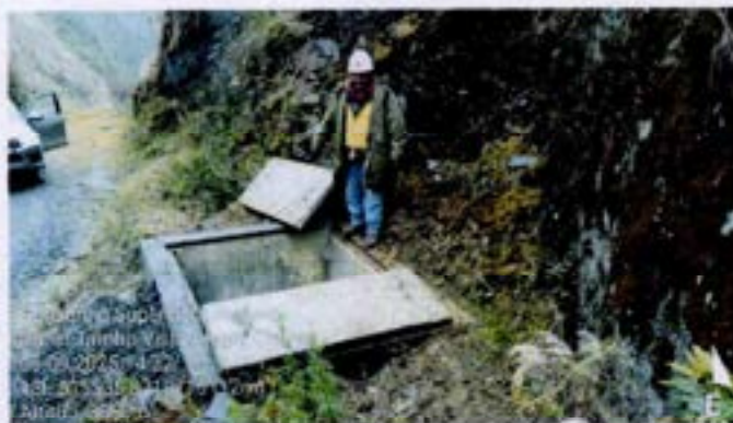
FOTO 10: LIMPIEZA DE CAJA DE INSPECCIÓN.
