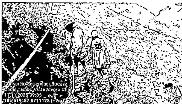
FOTO 19: VERIFICACION DE INSTALACION DE TUBERIA PVC DE 1".
