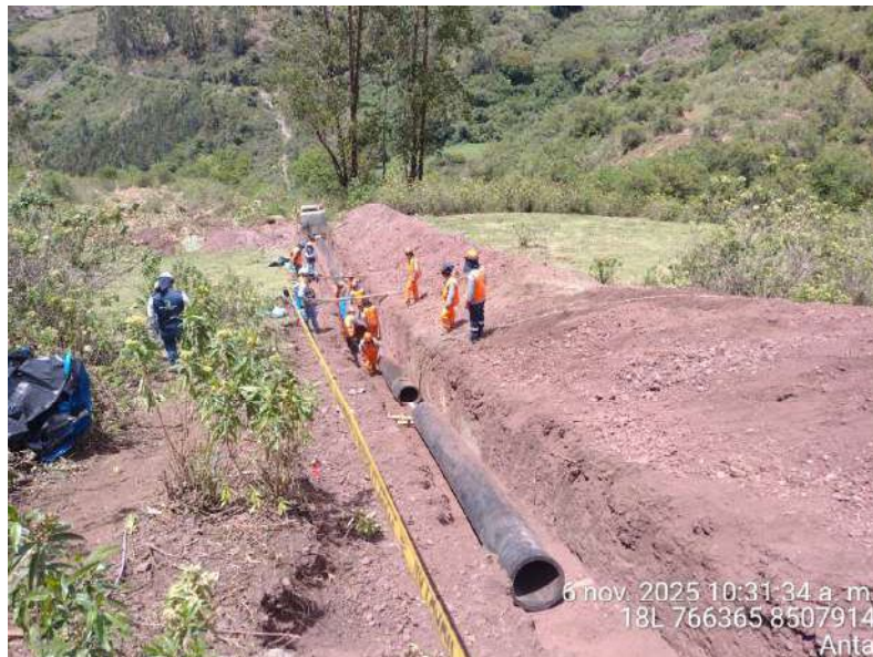
Figura N°16: 6 vistas que ilustran la colocación de la tubería en el sifón N°02 – suelos limo arcillosos
