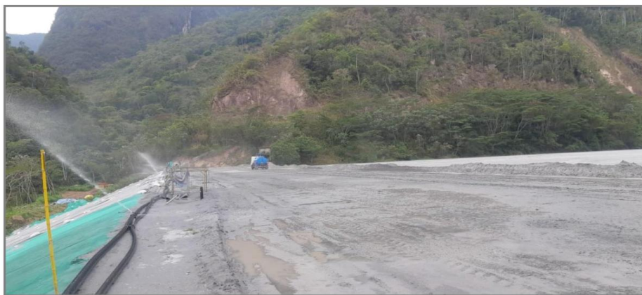
Imagen N° 8.- Vista de sistema de aspersores y uso de un camión cisterna
