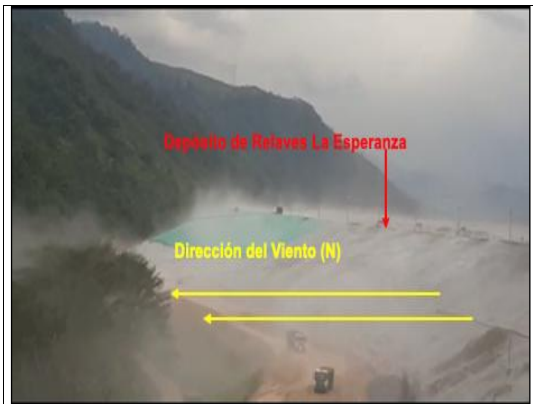
Fotografía N° 2 30 : Se observó la dispersión de material particulado por acción del viento del relave del Depósito de Relaves con dirección de norte a sur, con dirección hacia el Centro Poblado Santa Ana y al Río Tulumayo.
