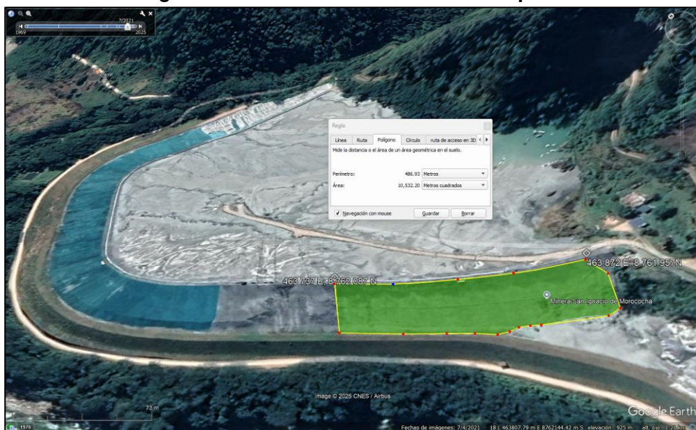
Figura n.º 1: Tramo del talud a la intemperie
