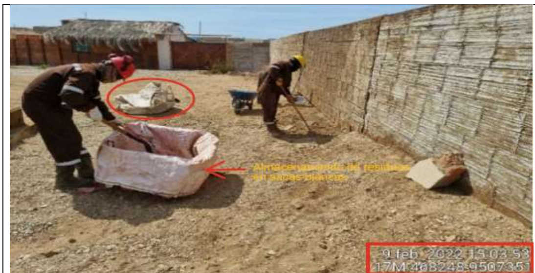
Cuadro N° 09: Imágenes de la limpieza del área afectada y almacenamiento inicial de los residuos sólidos peligrosos del día 09 de febrero de 2022
