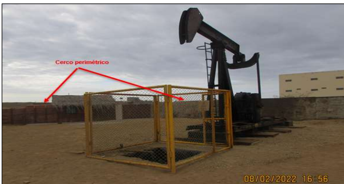
Imagen 05: instalación de cercos perimétricos
