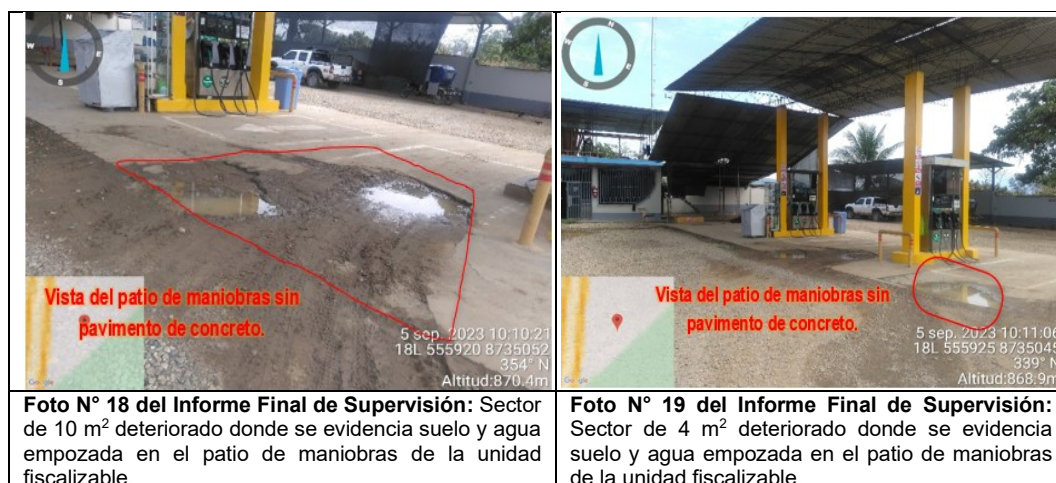
Cuadro N° 2: Fotografías de la verificación realizada en el patio de maniobras
