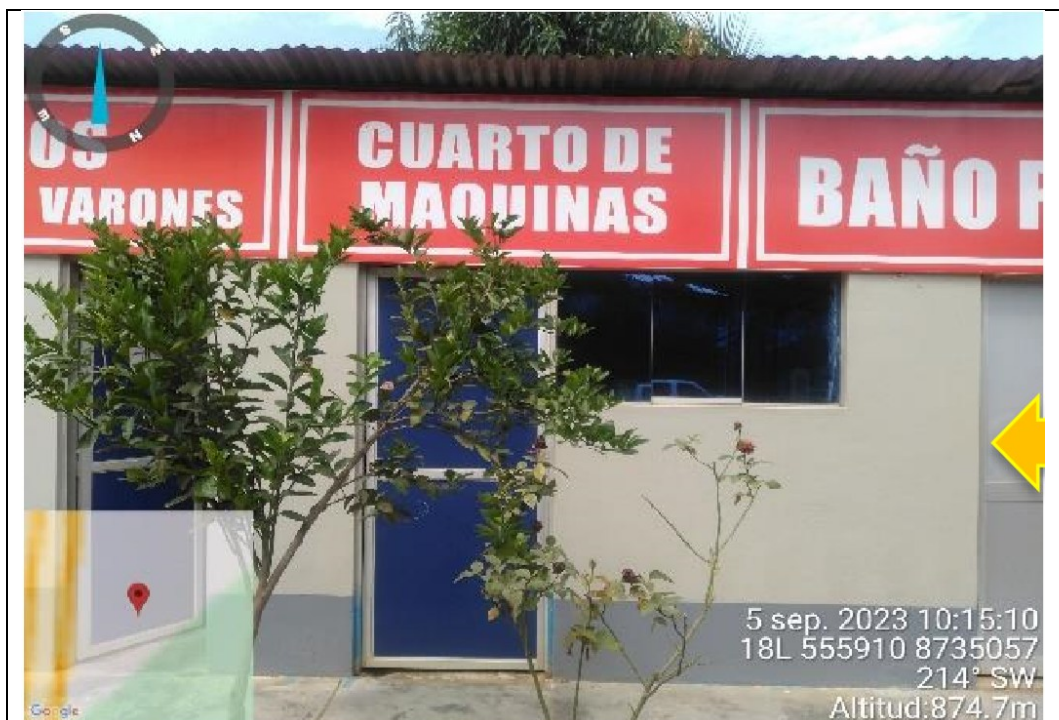
Fotografía del 5 de septiembre de 2023 del cuarto de máquinas con un cartel que indica “Cuarto de máquinas”.
