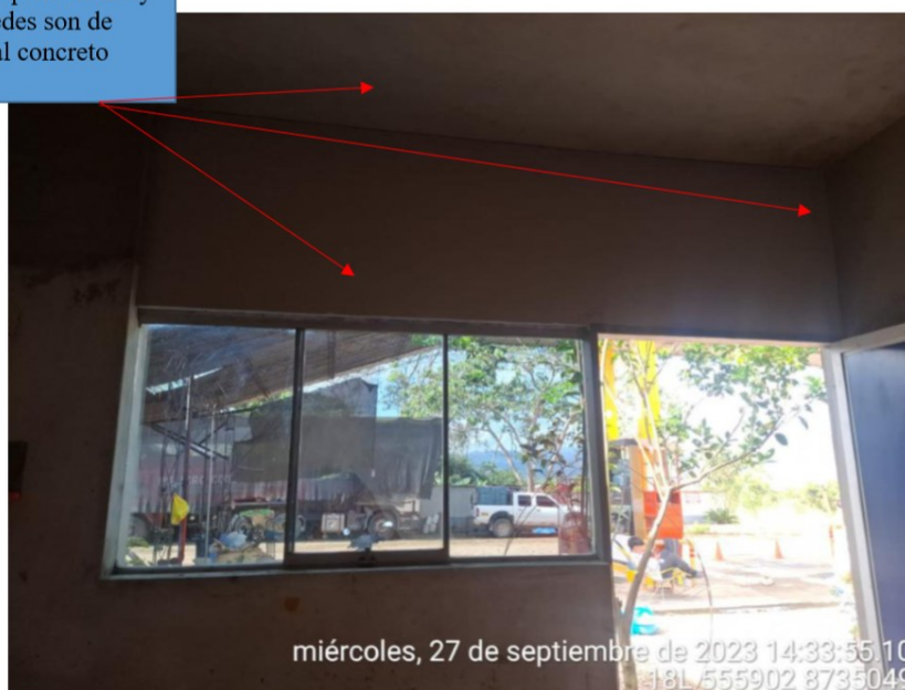
Fotografía del 27 de septiembre de 2023 del interior del cuarto de máquinas . Se muestra que las paredes y techos son de concreto.
