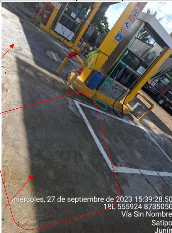
Fotografía del 27 de septiembre de 2023, presentada por el administrado, que evidencia que el Sector de 4 m 2 fue pavimentado
