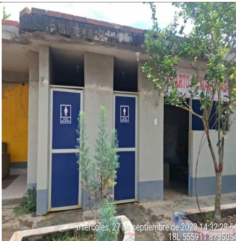
Fotografía del 27 de septiembre de 2023 del cuarto de máquinas con un cartel que indica “Cuarto de máquinas”.
