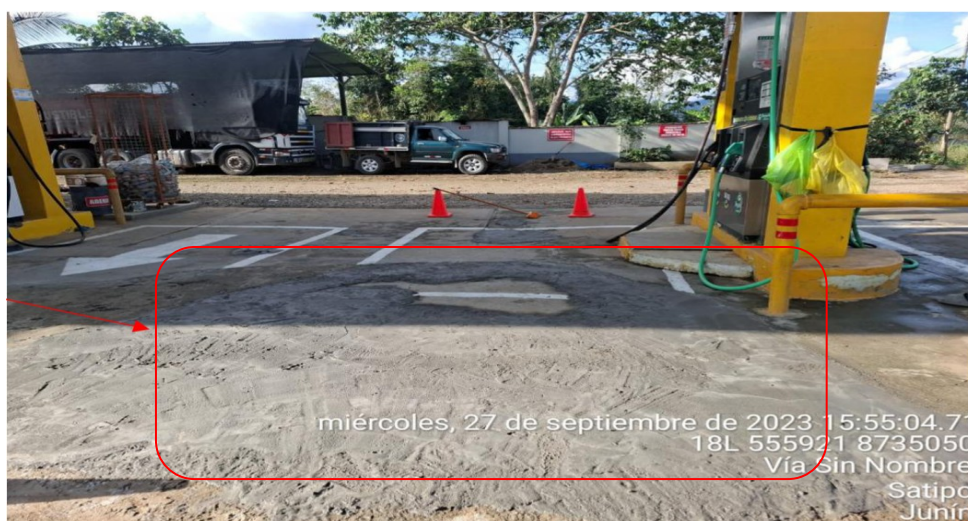
Fotografía del 27 de septiembre de 2023, presentada por el administrado, que evidencia que el Sector de 10 m 2 fue pavimentado
