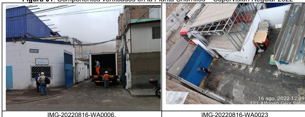
Figura 01: Componentes verificados en la Planta Chorrillos – Supervisión Regular 2022
