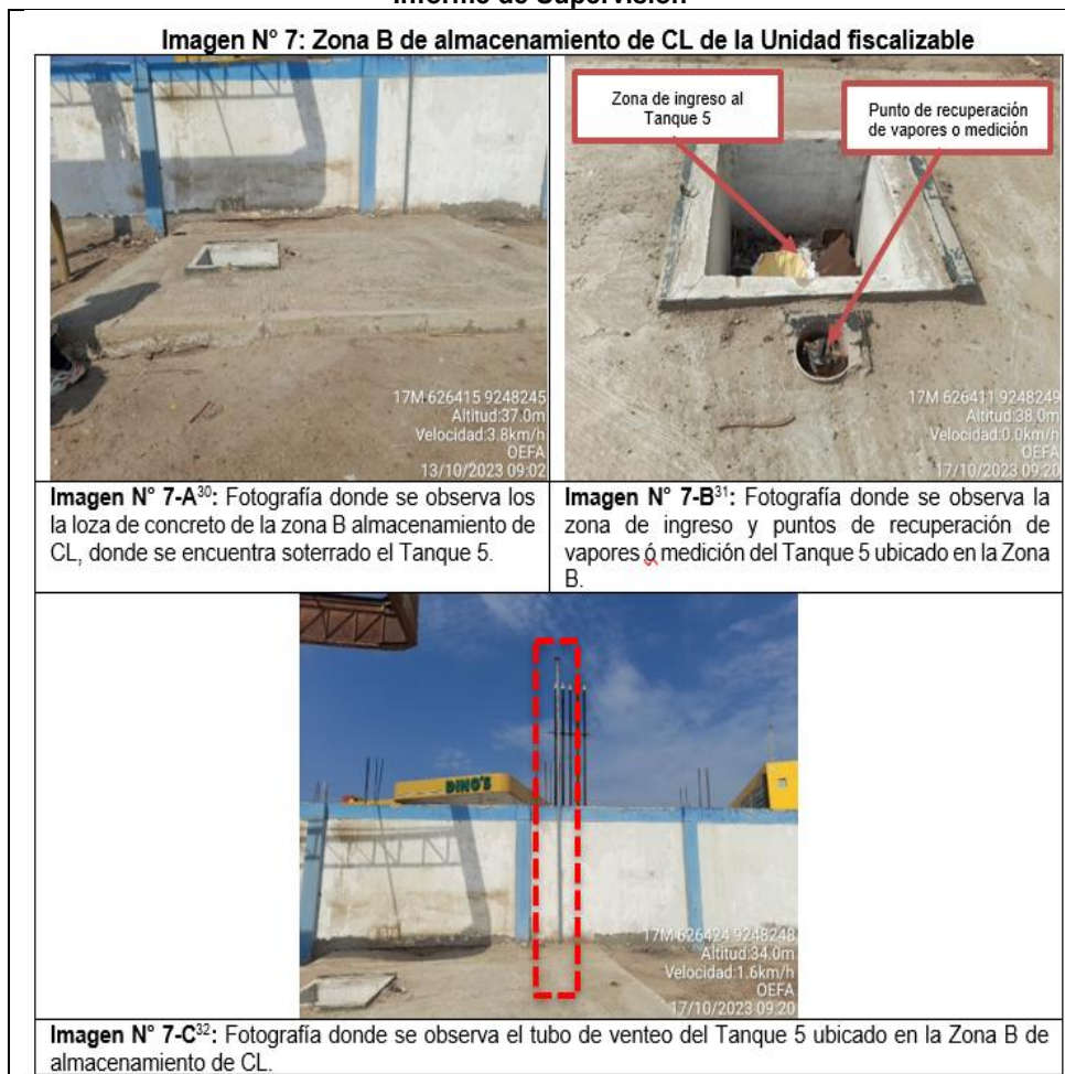
Imagen N° 7: Evidencia fotográfica referente al tanque 5 de la Zona B, extraída del Informe de Supervisión
