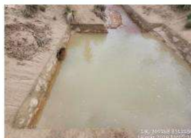
Fotografía N° 31. Archivo TimePhoto_20240314_100711, se observa la poza de mampostería que colecta las aguas del Depósito de desmonte N° 1 y la alcantarilla que derivaba 11,02 l/s aprox. directamente al río Chacapalca y 0,87 l/s hacia la poza de homogenización del STAA Andrés para su tratamiento.
