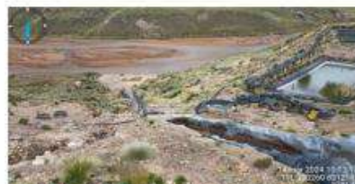
Fotografía N° 33. Archivo TimePhoto_20240314_101017, se observa la descarga de 11,02 l/s aprox. directamente de la poza de mampostería al río Chacapalca
