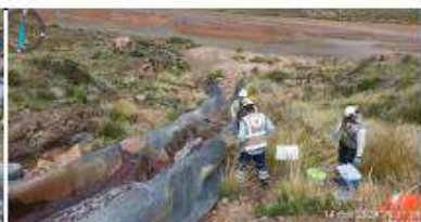
Fotografía N° 34. Archivo TimePhoto_20240314_103108, se observa la descarga de 11,02 l/s aprox. directamente de la poza de mampostería al río Chacapalca
