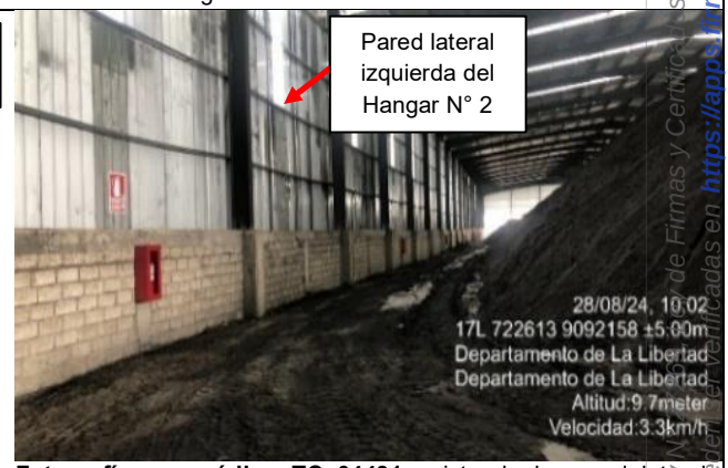
Fotografía con código TC_04431.- vista de la pared lateral izquierda del Hangar N° 2.
