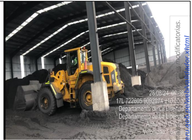
Video con código TC_04428.- vista del apilamiento del carbón en el interior del Hangar N° 2.
