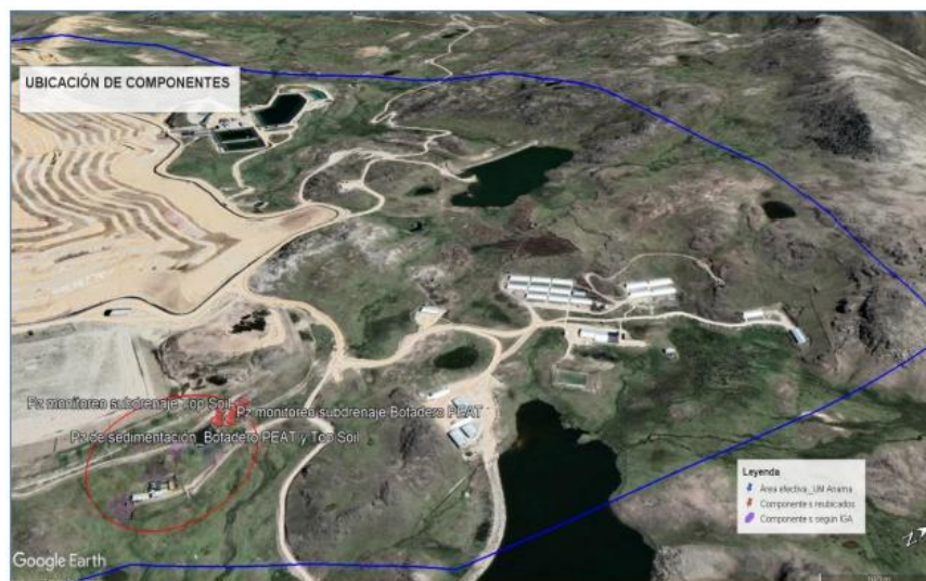
Imagen N° 1: Vista de la ubicación de las pozas materia del presente hecho imputado con la ubicación aprobado en el instrumento de gestión ambiental. Nótese que, la reubicación de dichos componentes se encuentra dentro del área efectiva del proyecto minero Anama; asimismo, se puede observar que la reubicación se ha realizado en un radio comprendido entre los 25 y 100 m lineales.
