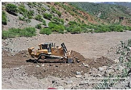
Imagen 34. Se aprecia 01 tractor sobre orugas realizando trabajos de limpieza de la quebrada Chuzal - Huabal.
