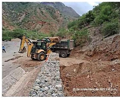
Imagen 36. Se aprecia las actividades de eliminación de material depositado en la parte posterior de la estructura tipo gavión.
