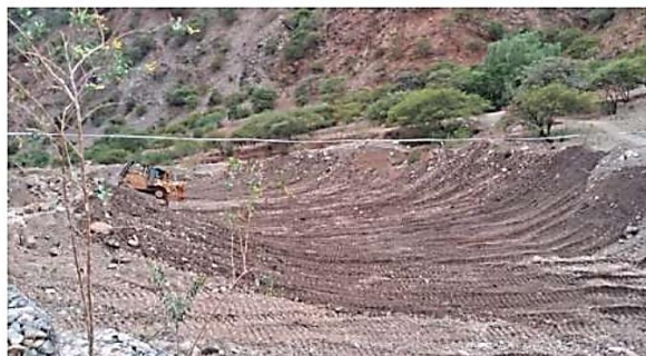
Imagen 33. Se aprecia los trabajos de limpieza y descolmatación en cauce de la quebrada.
