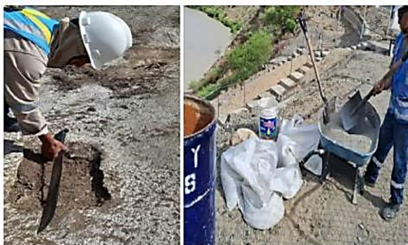
Imagen 31. (A la izquierda) Limpieza del área a sellar con mortero. (A la derecha) preparación de mortero para sellado de capa de shotcrete.
