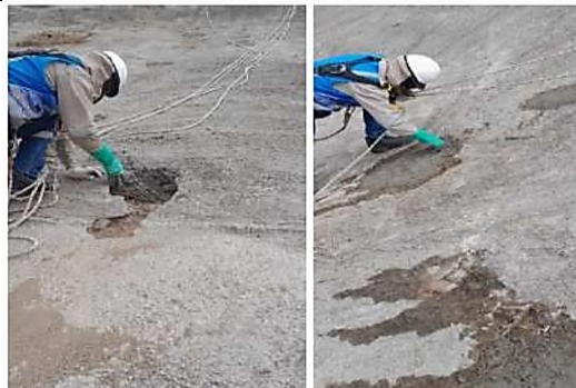
Imagen 32. Se aprecia la reparación del revestimiento de concreto por el método de pañeteo.
