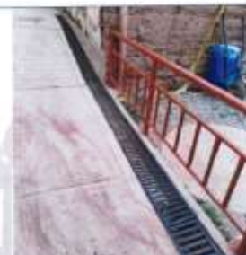
IMAGEN 04: Canales de conducción con rejillas metálicas de aguas residuales
