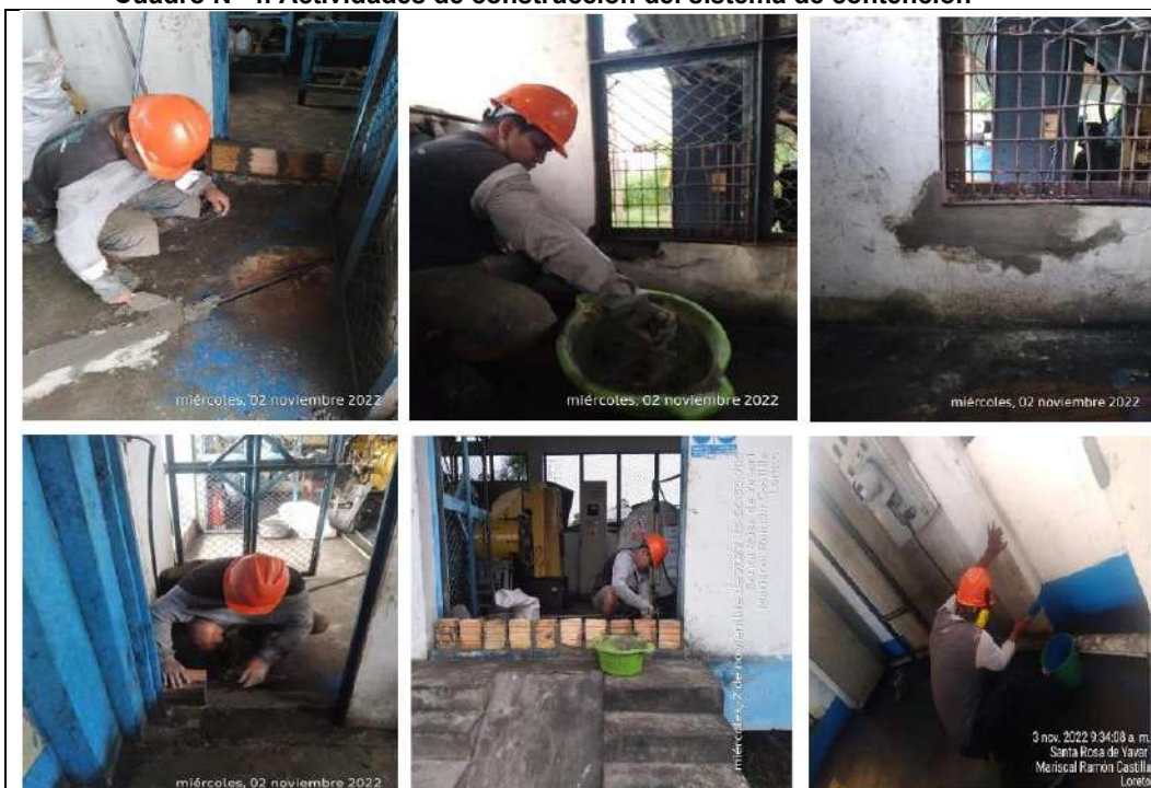
Cuadro N° 4. Actividades de construcción del sistema de contención
