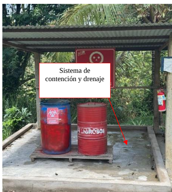
Figura n.º 4: Implementación de Sistema de contención y drenaje
