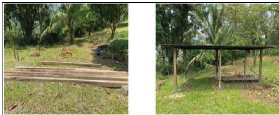
Figura n.º 1: Implementación del techo
