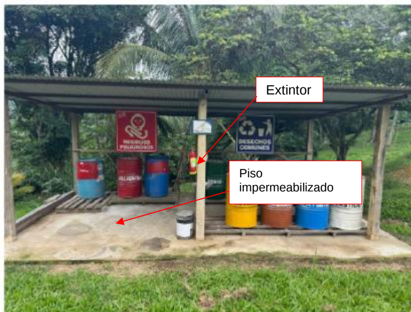
Figura n.º 3: Implementación de piso de concreto e implementación del extintor
