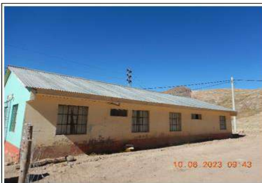
Fotografía N° 94. (DSCN0647) Vista de las instalaciones de centro médico en desuso, con techos puertas, ventanas.
