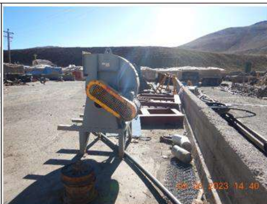
Fotografía N° 73. (DSCN0603) Otra vista de la zona de plataforma de cargueros, al fondo se observaron volquetes cuadrados que van a la UM Tacaza, conforme a o mencionado por CIEMSA
