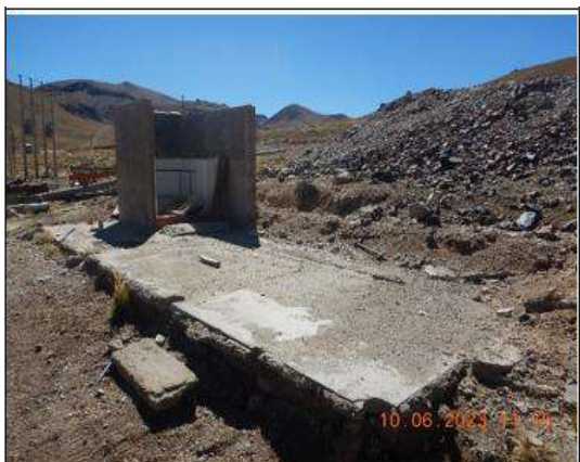
Fotografía N° 62. (DSCN0659) Vista de la zona de depósito de insumos planta, donde se aprecia la losa de concreto y muros de ladrillo
