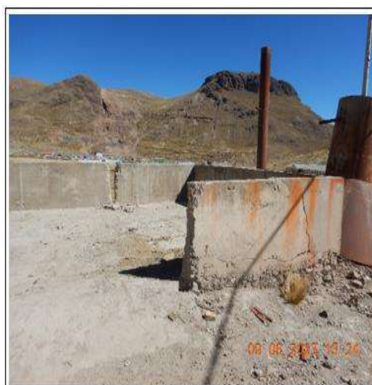
Fotografía N° 60. (DSCN0363) Vista de la zona del almacén de reactivos donde se aprecia las losas y muros de concreto
