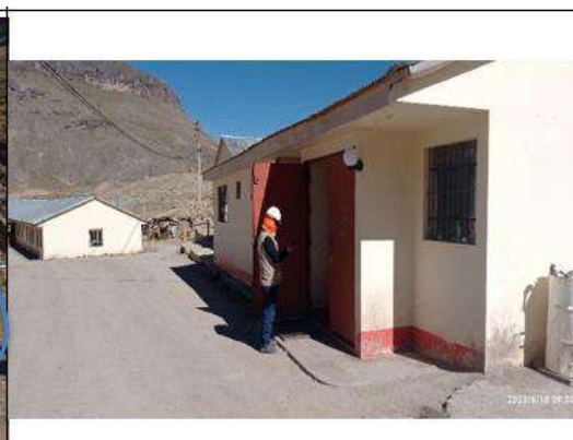
Fotografía N° 93. (IMG_20230610_093039) Vista de las oficinas administrativas compañía, estructuras de concreto y ladrillo en uso
