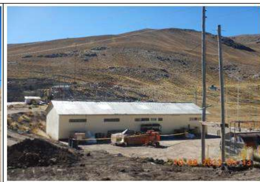
Fotografía N° 95. (DSCN0650) Vista de la zona de almacén general, en uso
