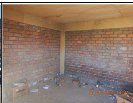
Fotografía N° 91. (DSCN0035) Otra vista de la las oficinas mina, pisos de concreto, cielo raso de madera.
