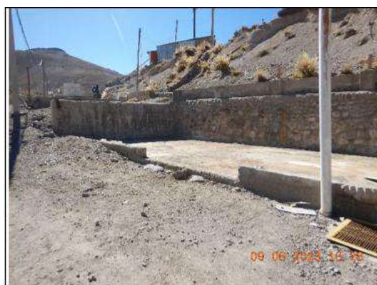
Fotografía N° 86. (DSCN0377) vista del taller mecánico eléctrico, se observa pisos de concreto y muros
