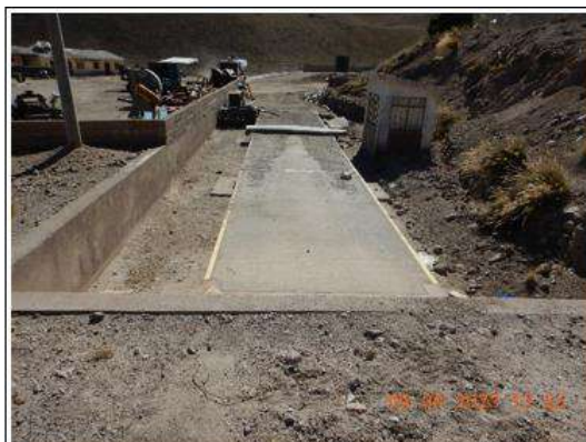
Fotografía N° 74. (DSCN0357) Vista la balanza hidráulica
