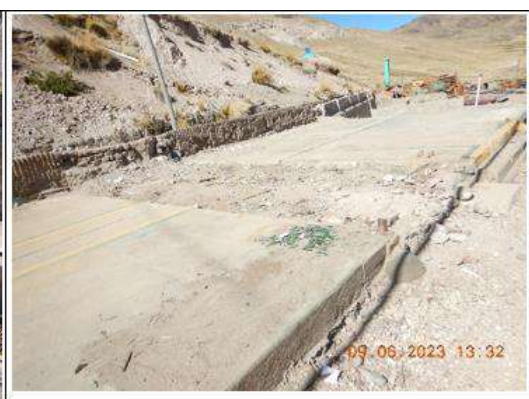
Fotografía N° 87. (DSCN0386) otra vista de la zona del taller mecánico eléctrico.
