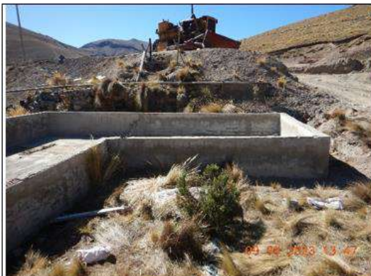
Fotografía N° 68. (DSCN0442) Vista de la zona de almacén de combustibles, se aprecia las losas de concreto de la zona de contención
