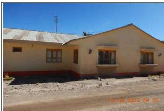
Fotografía N° 98. (DSCN0632) otra vista de la zona de campamentos de la unidad, estructuras de ladrillo y concreto con techos de calamina
