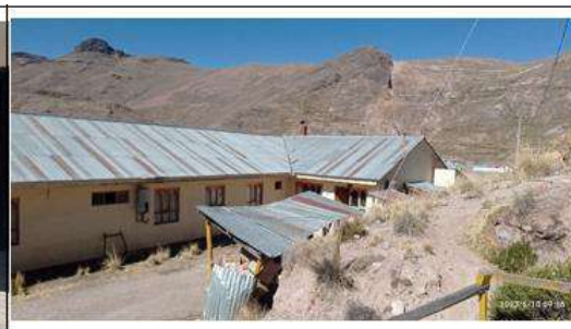
Fotografía N° 97. (IMG_20230610_093658) Vista de la zona de campamento de la Unidad minera, en uso.
