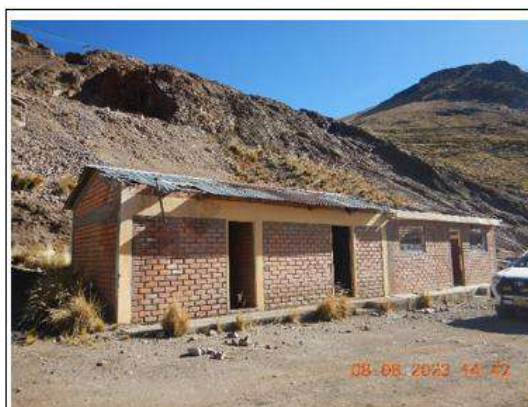
Fotografía N° 90. (DSCN0039) Vista de la zona de las oficinas mina, con edificaciones de ladrillo y techos de calamina
