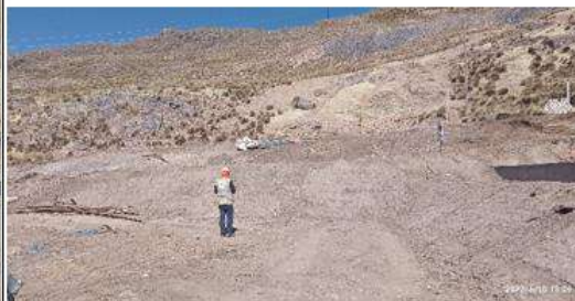
Fotografía N° 71. (IMG_20230610_130613) Vista de la zona de cancha de transferencia de mineral cercana a la bocamina Nv. 00.
