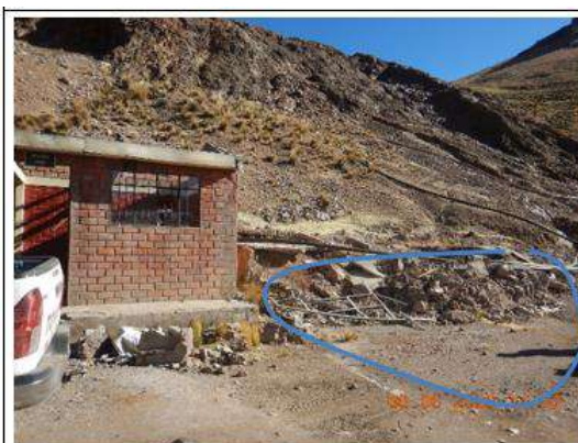
Fotografía N° 92. (DSCN0659) Vista de la zona donde se encontraban las oficinas COEMPSA, sin infraestructura con material acumulado
