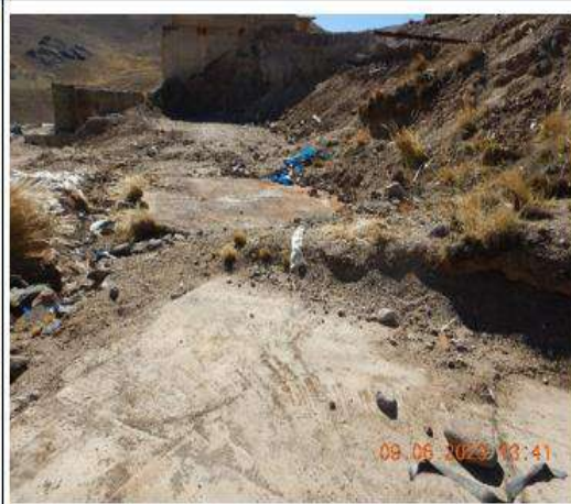
Fotografía N° 59. (DSCN0423) Otra vista de la zona del tanque de agua SMA-3, solo se aprecia la losa de concreto
