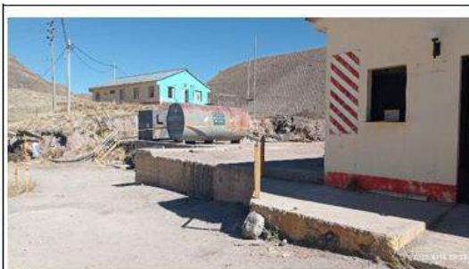
Fotografía N° 96. (DSCN0446) Otra vista de la zona del almacén general con las plataformas de descarga de concreto, instalaciones en uso a la fecha de supervisión
