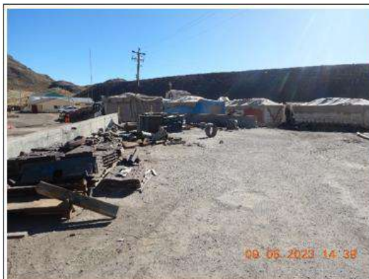
Fotografía N° 72. (DSCN0590) Vista de la zona de plataforma de cargueros, con presencia de estructuras metálicas y muros y piso de concreto
