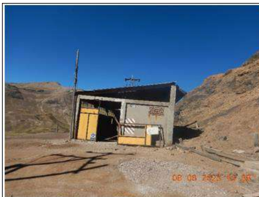
Fotografía N° 76. (DSCN9979) vista de la casa compresora, columnas de concreto, muros de ladrillo techos de calamina.
