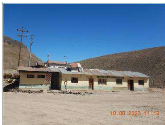
Fotografía N° 78. (DSCN0667) vista de las instalaciones del laboratorio metalúrgico químico, frente a la planta concentradora
