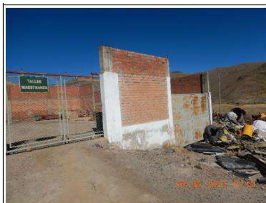
Fotografía N° 88. (DSCN0466) vista del taller de maestranza, el cual se encuentra cerrado, se observa construcción de ladrillo y columnas de concreto
