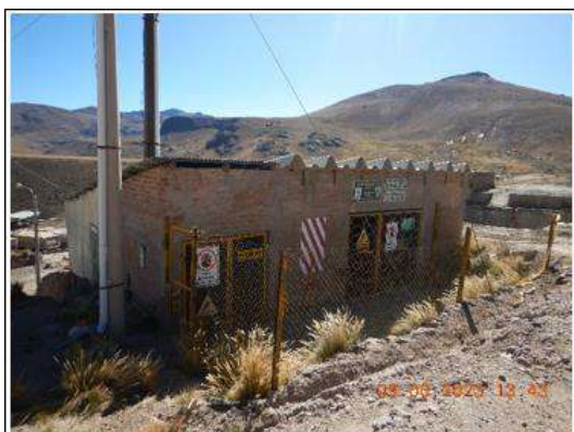
Fotografía N° 84. (DSCN0430) Vista de la sub estación eléctrica Planta, estructuras de concreto y ladrillo, con techos y puertas metálicas con mallas.
