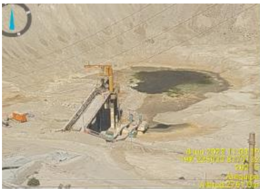
Fotografía N° 9. Vista panorámica del MEGA PAD ROM
