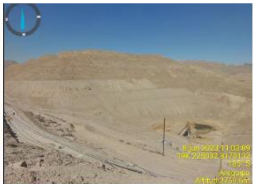
Fotografía N° 10. Vista panorámica del MEGA PAD ROM
