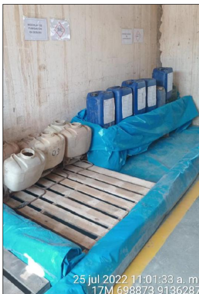
Imagen 6. Residuos Peligrosos almacenados en el Almacén de Residuos Peligrosos de la EMPRESA AGRÍCOLA SINTUCO conforme al ítem c) y d) con sistema de contención, con pasillo que permita el desplazamiento de personal y piso de material resistente (piso cemento).
