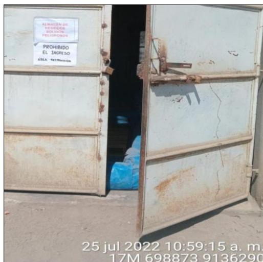
Imagen 3. Ingreso a Almacén de Residuos Peligrosos en la EMPRESA AGRÍCOLA SINTUCO conforme al ítem a ) Área acondicionada y techada.
