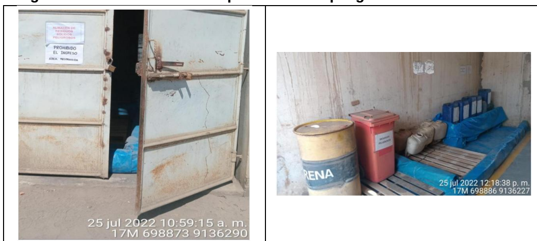
Figura n.° 2: Almacén central para residuos peligrosos del administrado
