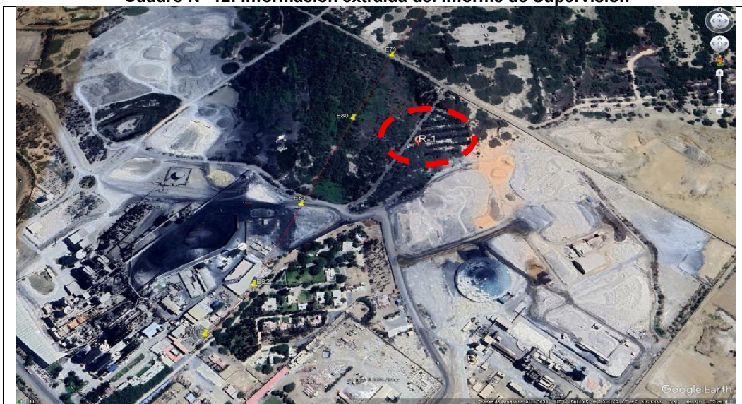
Imagen N° 32 del Informe de Supervisión: Ubicación de la estación R-1 con la siguiente descripción: Poste N°76, futura línea de transmisión.
