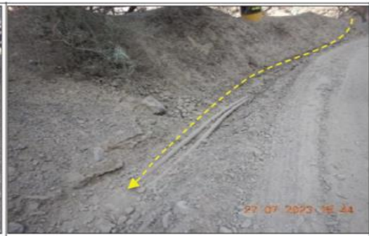
Fotografía N° 2013 58 : Se observó la línea de rebose las tuberías de derivación del DD-CO-02 hacia el sistema de tratamiento.
