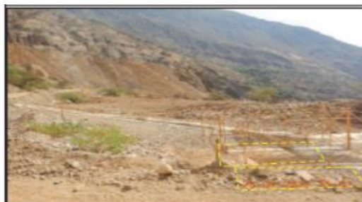
Fotografía N° 214 59 : Se observó ambas pozas colectoras del depósito de desmonte DD-CO-06.
