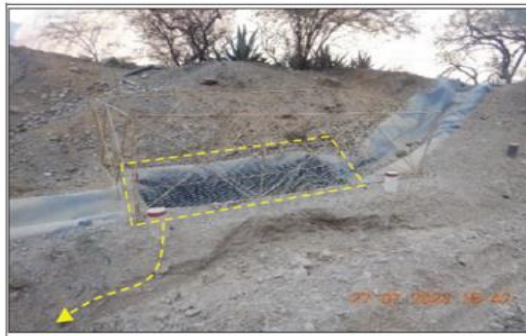
Fotografía N° 129 57 : Se observó la poza colectora del depósito de desmonte DD-CO-02, con línea de rebose enterrado.
