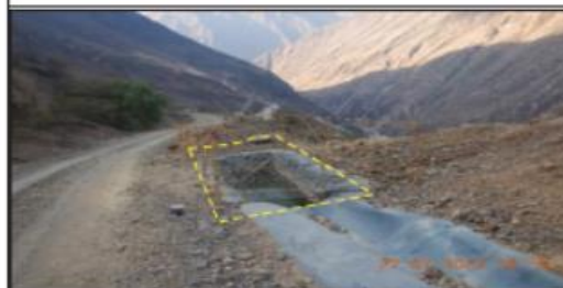
Fotografía N° 16 61 : Se observó poza colectora de la parte alta del depósito de desmonte DD-CO-07.
