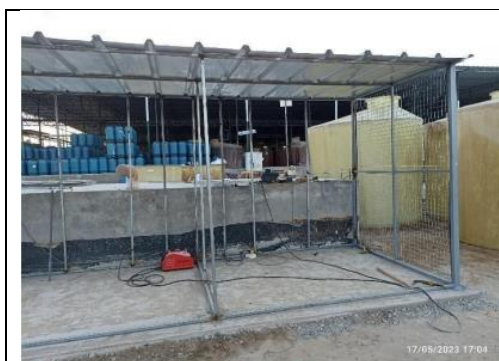
Fotografía N° 1.- Vista del proceso de construcción del almacén de RRSS peligrosos.
