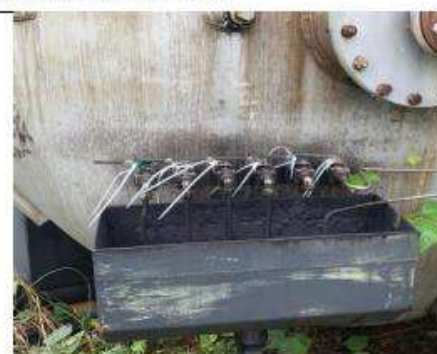
FOTO N° 02: colocación de precintos de seguridad a las válvulas (Foto del 13.04.2023 tomada durante la supervisión)
