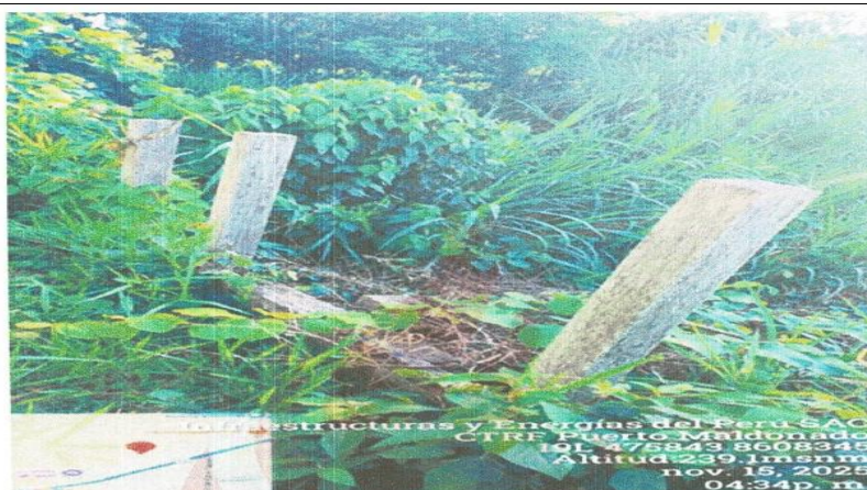
Figura 2. Estado del talud con vegetación estabilizada. Fecha: 15/11/2025.
