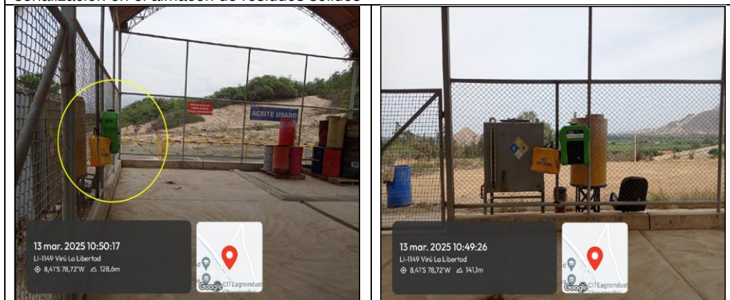
Imagen N° 8: Implementación de kit de emergencia antiderrames y equipo de sanitización (ducha lava ojos)
