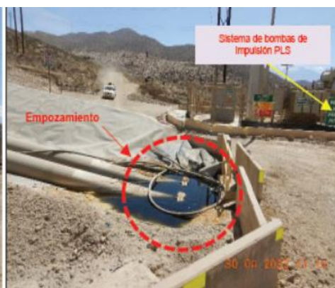
Fotografía N° 10. Vista a detalle del empozamiento en el canal de contención de la línea de impulsión de PLS, aguas abajo del PAD 4B. (Código DSCN4295).
