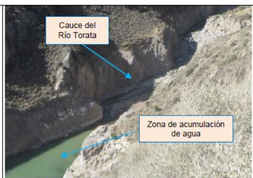
FOTOGRAFIA N° 17.- No se observa ninguna estructura para la retención de sólidos, aguas arriba de la zona de acumulación de agua.
