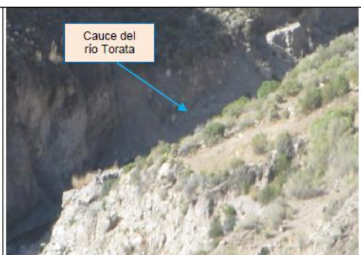
FOTOGRAFIA N° 15.- Continuación del cauce del río Torata, ubicado aguas arriba de la presa de regulación. No se observa ninguna estructura para la retención de sólidos y sedimentos.
