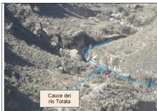
FOTOGRAFIA N° 14.- Acercamiento del cauce del río Torata, aguas arriba de la presa de regulación. No se observa ninguna estructura de retención de sólidos y sedimentos.
