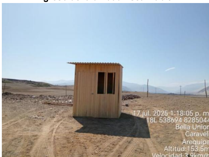
Imagen n.º 14: Vista de caseta de control instalados en el ingreso de la unidad fiscalizable
