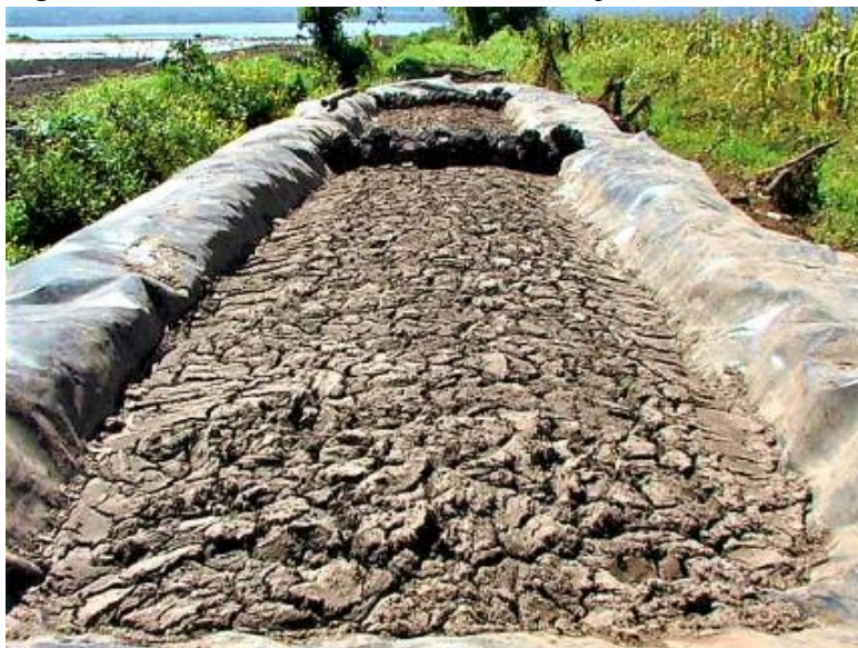
Figura n.º 5: Área de almacenamiento y secado de lodos
