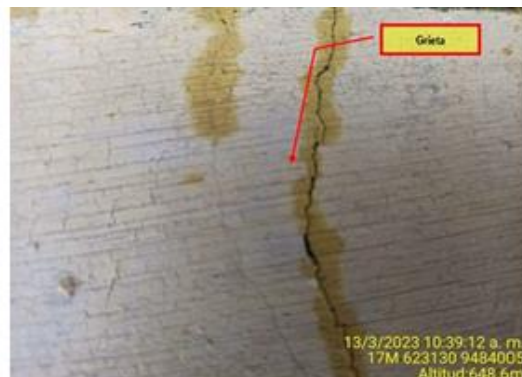
Fotografía N° 14 del Informe de Supervisión: Grieta sobre el muro de contención del grupo electrógeno.
