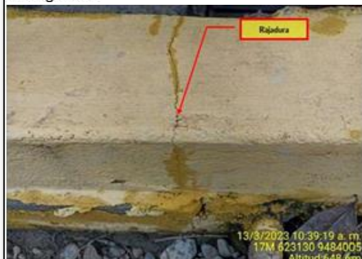
Fotografía N° 13 del Informe de Supervisión: Rajadura sobre el muro de contención del grupo electrógeno.
