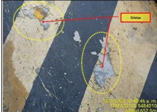
Fotografía N° 15 del Informe de Supervisión: Deterioro del piso interior del sistema de contención.
