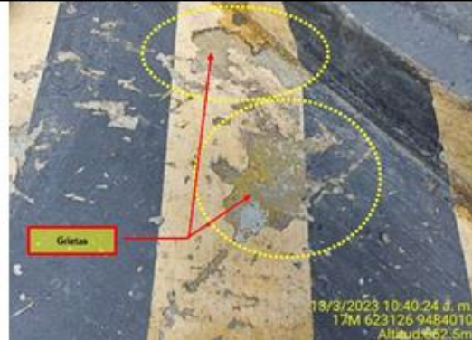
Fotografía N° 16 del Informe de Supervisión: Orificios del piso del sistema de contención del grupo electrógeno.
