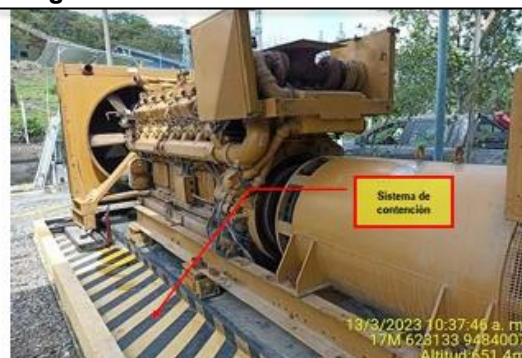
Fotografía N° 10 del Informe de Supervisión: Sistema de contención del grupo electrógeno.
