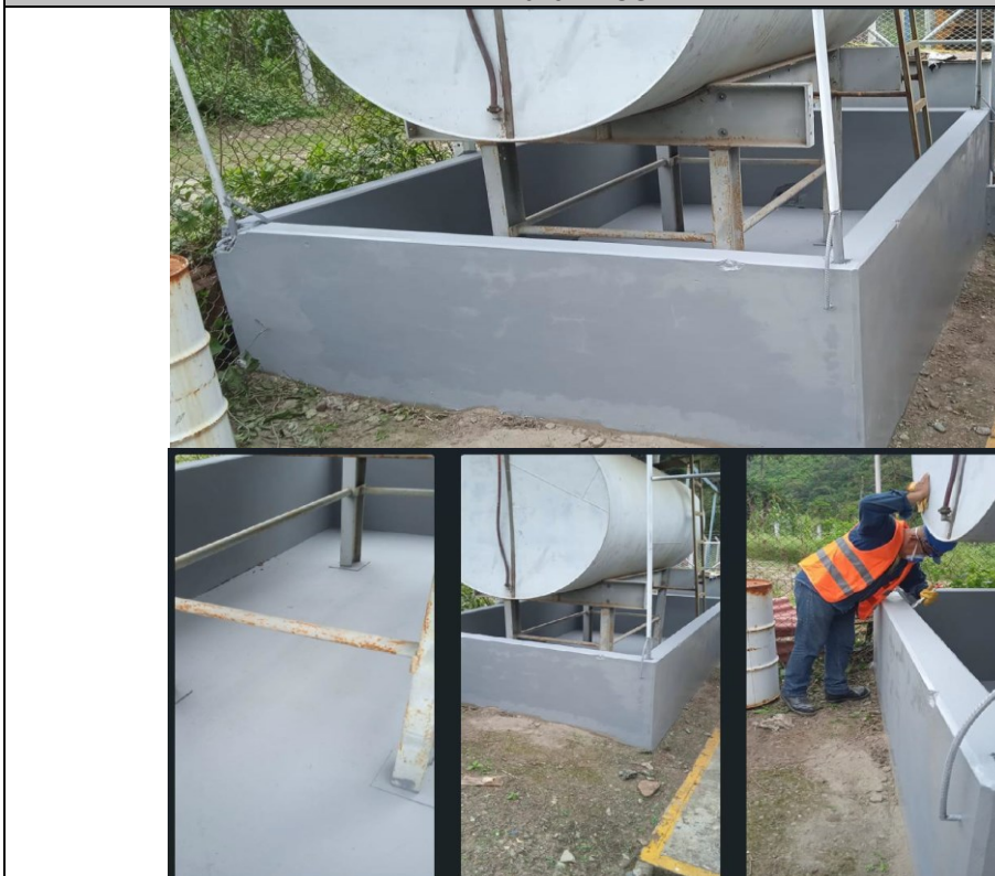
Fig. 04: Impermeabilización de contención de tanque de combustible
