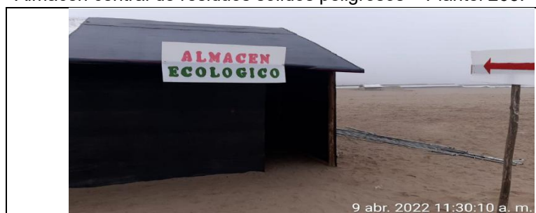
Almacén central de residuos sólidos peligrosos – Plantel 265:
