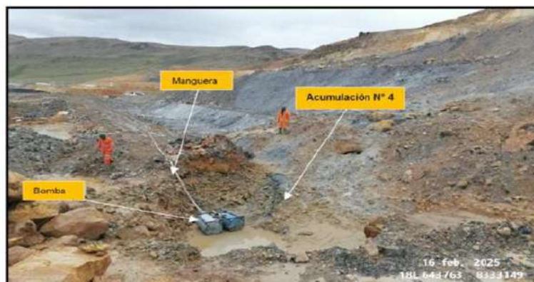
Se visualiza Poza, denominada como "Acumulación 4". Donde se aprecia que después de realizar trabajos de bombeo, se acredita que cumple todas las características de una calicata.
