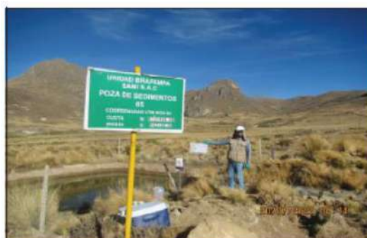
Fotografía 78. Vista de la poza de sedimentación N° 05 (SED-4), excavada en el terreno superficial, dicha poza presentaba agua en el interior. (ver archivo: IMG_0673).
