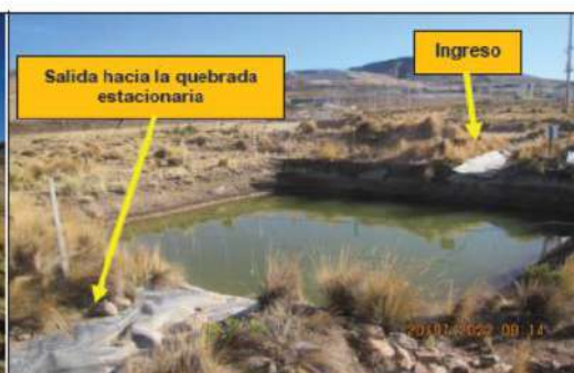
Fotografía 79. Vista de la poza de sedimentación N° 05 (SED-4), presentaba un canal de geomembrana que ingresaba a dicha poza, proveniente de la cuneta de la vía de acceso de la zona de operaciones que interconecta el campamento con el tajo abierto y su ampliación, así como, el pad de lixiviación y depósito de desmonte. Asimismo, presentaba un canal de salida hacia la quebrada estacionaria. (ver archivo: IMG_0679).
