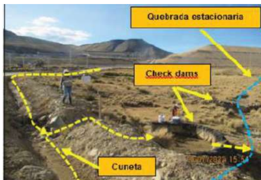
Fotografía 84. Vista de una de las estructuras para el manejo de sedimentos (check dams) ubicada en la quebrada estacionaria, codificada como punto SED-2. A dicha estructura se unían las cunetas de la vía de acceso de la zona de operaciones que interconecta el campamento con el tajo abierto y su ampliación, así como, el pad de lixiviación y depósito de desmonte (ver archivo: IMG_0649).
