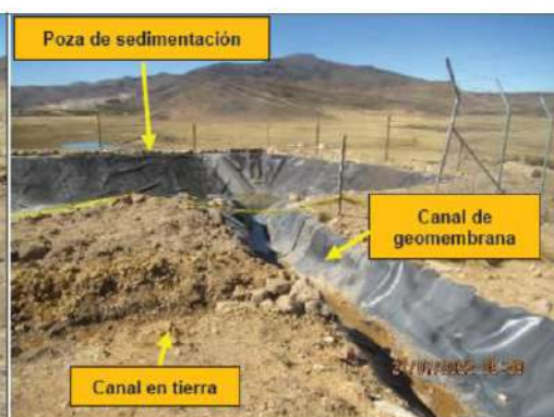
Fotografía 72. Vista de la poza de sedimentación revestida con geomembrana (no presentaba salida hacia el suelo circundante), canal hecho entierra proveniente del área donde se ubicaba el afloramiento ESP-13 y del canal de geomembrana proveniente del área donde se ubican el polvorín y al almacén de nitrato. (Fuente: fotografía IMG_0810).
