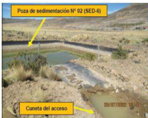
Fotografía 82. Vista de la poza de sedimentación N° 02 (SED-6), presentaba un canal de geomembrana que ingresaba a dicha poza, proveniente de la cuneta de la vía de acceso de la zona de operaciones que interconecta el campamento con el tajo abierto y su ampliación, así como, el pad de lixiviación y DME. Asimismo, presentaba
