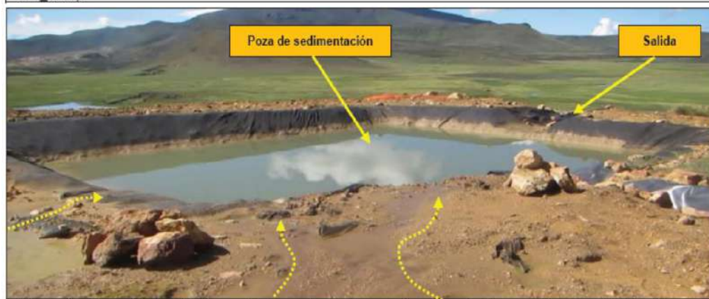
Fotografía 70. Captura de imagen donde se observa la poza de sedimentación revestida con geotextil y el ingreso de los flujos de agua provenientes del afloramiento ESP-13, dicha poza presentaba una salida hacia el suelo circundante y el ingreso de un canal revestido con geomembrana provenientes del área donde se ubicaban el polvorín y almacén de nitrato. (Fuente: MVI_3933).
