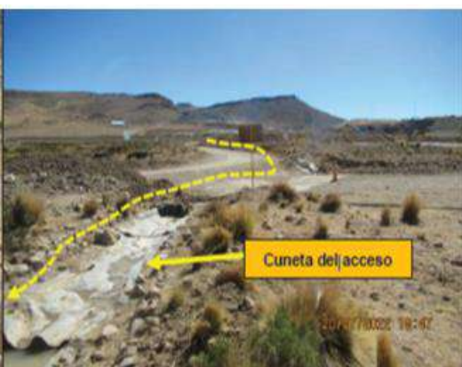
Fotografía 83. Vista del canal de geomembrana que ingresaba a la poza de sedimentación N° 02 (SED-6), proveniente de la cuneta de la vía de acceso de la zona de operaciones que interconecta el campamento con el tajo abierto y su ampliación, así como, el pad de lixiviación y DME. (ver archivo: IMG_0701).
