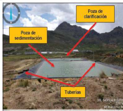
Fotografía 9. Vista de la poza de sedimentación y poza de clarificación, ambas pozas se encontraban revestidas con geomembrana. La poza de sedimentación presentaba 2 tuberías de ingreso y una estructura de paso (vertedero) hacia la poza de clarificación (Fuente: Fotografía TimePhoto_20220406_141404).
