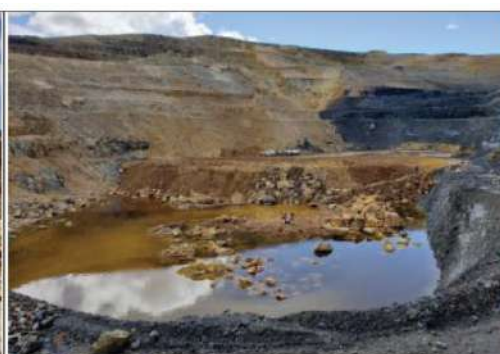
Fotografía 30. Vista del interior del tajo abierto, conformado por bancos, se observaron algunos tramos perfilados (talud y plataforma) y en otros tramos se observó presencia de rocas y material suelto, asimismo, en el fondo del referido tajo se evidenció acumulación de agua con características ácidas. (Fuente: Fotografía 20220408_101153 del Acta de Supervisión de la acción de supervisión realizada del 25 de marzo al 5 de mayo de 2022).
