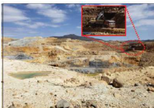
Fotografía 29. Vista del interior del tajo abierto, conformado por bancos perfilados y presencia de rocas y material suelto, así como, acumulación de agua con características ácidas en el fondo del referido tajo y actividades de retiro de material en las paredes de los bancos con maquinaria de línea amarilla (volquete y excavadora). (Fuente: Fotografía 20220208_144826 del Acta de Supervisión de la acción de supervisión realizada del 31 de enero al 25 de febrero de 2022).
