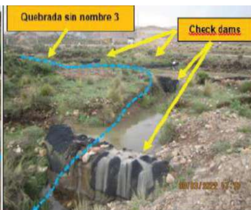
Fotografía 89. Vista de los check dams ubicado en la quebrada sin nombre 3, cerca al punto de muestreo QSnom3-C. Se observó flujo de agua que discurría por dicha quebrada. (ver archivo: IMG_2755).
