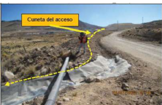
Fotografía 81. Vista del canal de geomembrana que ingresaba a la poza de sedimentación N° 04 (SED-5), proveniente de la cuneta de la vía de acceso de la zona de operaciones que interconecta el campamento con el tajo abierto y su ampliación, así como, el pad de lixiviación y depósito de desmonte. (ver archivo: IMG_0687).
