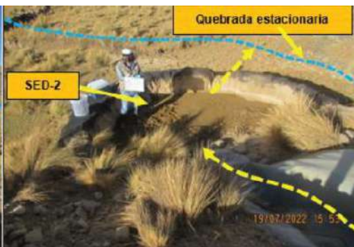
Fotografía 85. Vista de los sedimentos acumulados en el interior del check dam codificado como SED-2, ubicado en la quebrada estacionaria, codificada como punto SED-2. (ver archivo: IMG_0646).
