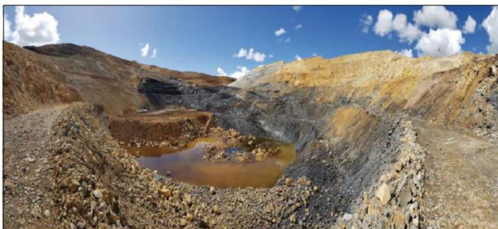
Fotografía 28. Vista panorámica del interior del tajo abierto, conformado por bancos, se observaron algunos tramos perfilados (talud y plataforma) y en otros tramos se observó presencia de rocas y material suelto, asimismo, en el fondo del referido tajo se evidenció acumulación de agua con características ácidas. (Fuente: Fotografía 20220408_100958 del Acta de Supervisión de la acción de supervisión realizada del 25 de marzo al 5 de mayo de 2022).
