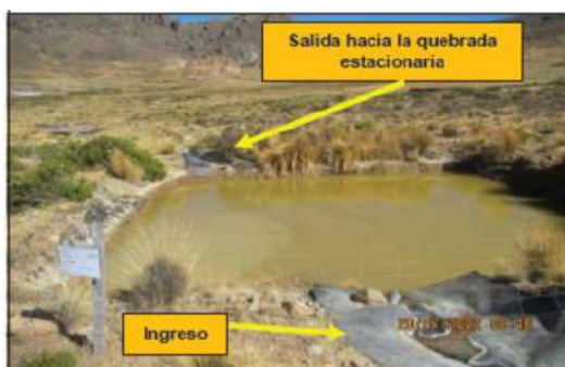
Fotografía 80. Vista de la poza de sedimentación N° 04 (SED-5), presentaba un canal de geomembrana que ingresaba a dicha poza, proveniente de la cuneta de la vía de acceso de la zona de operaciones que interconecta el campamento con el tajo abierto y su ampliación, así como, el pad de lixiviación y depósito de desmonte. Asimismo, presentaba un canal de salida hacia la quebrada estacionaria. (ver archivo: IMG_0689).
