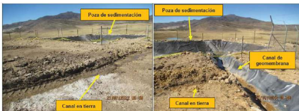
Fotografía 71. Vista de la poza de sedimentación revestida con geomembrana y canal hecho entierra proveniente del área donde se ubicaba el afloramiento ESP-13. (Fuente: fotografía IMG_0805).
