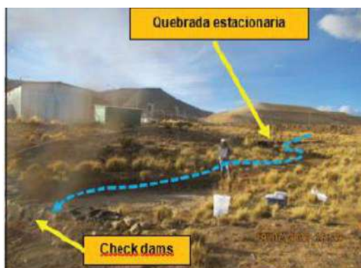
Fotografía 86. Vista de una de las estructuras para el manejo de sedimentos (check dams) ubicada en la quebrada estacionaria, codificada como punto SED-3. En el interior de dicha estructura se evidenció sedimentos acumulados. (ver archivo: IMG_0649).
