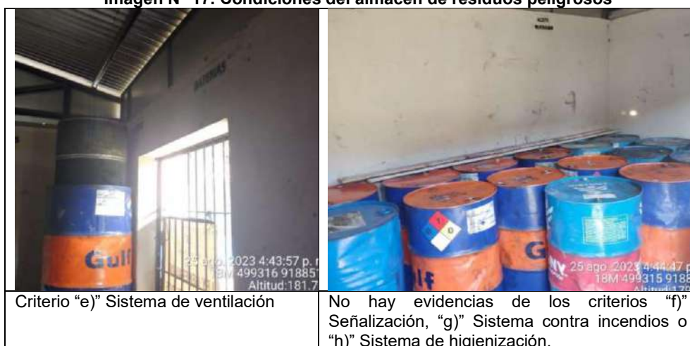
Imagen N° 17. Condiciones del almacén de residuos peligrosos
