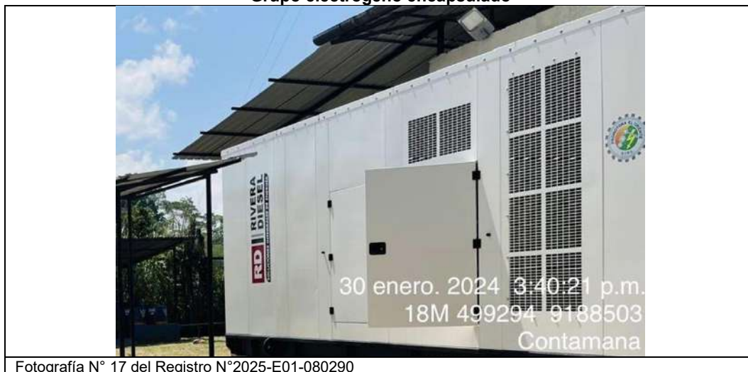
Grupo electrógeno encapsulado
