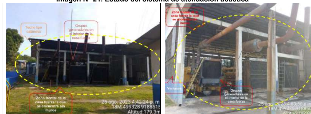
Imagen N° 21. Estado del sistema de atenuación acústica
