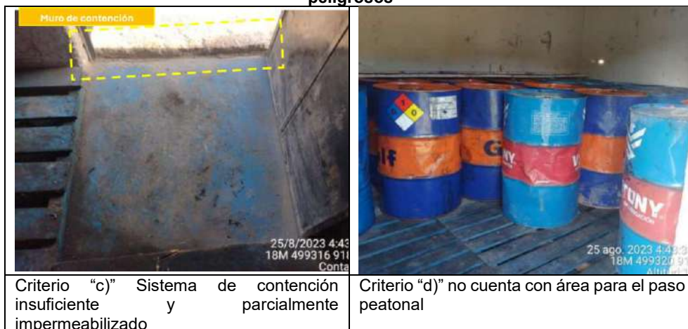
Imagen N° 16. Muro de contención y paso peatonal del almacén de residuos peligrosos
