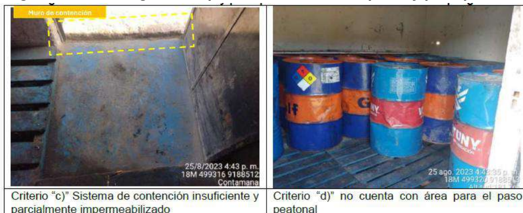
Figura n.º 3: Hallazgos de supervisión del almacén (muro y paso peatonal)
