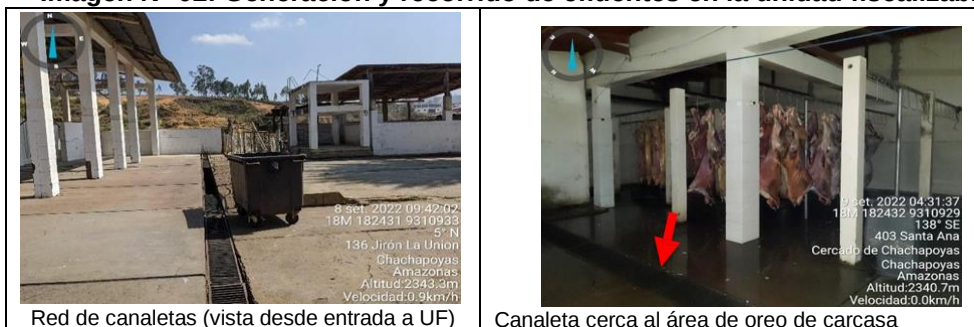
Imagen N° 02: Generación y recorrido de efluentes en la unidad fiscalizable
