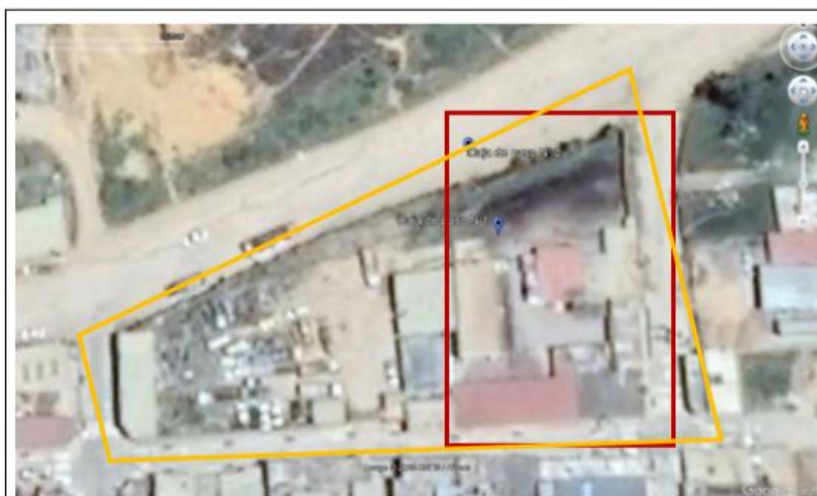
Imagen N.º 1: Imagen satelital de octubre de 2017 en Google Earth, cuando el Camal Municipal de Chachapoyas, se encontraba en funcionamiento. El recuadro rojo, es donde se encontraba emplazado el Camal Municipal.
